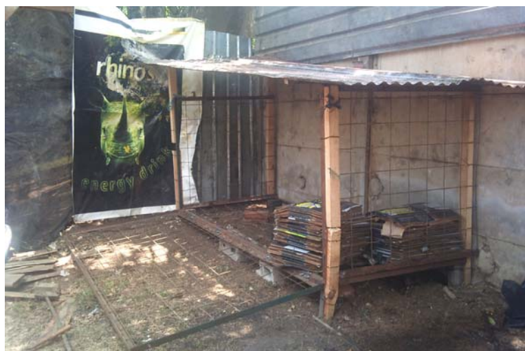
Figura 18. Estructura del depósito de reciclaje
