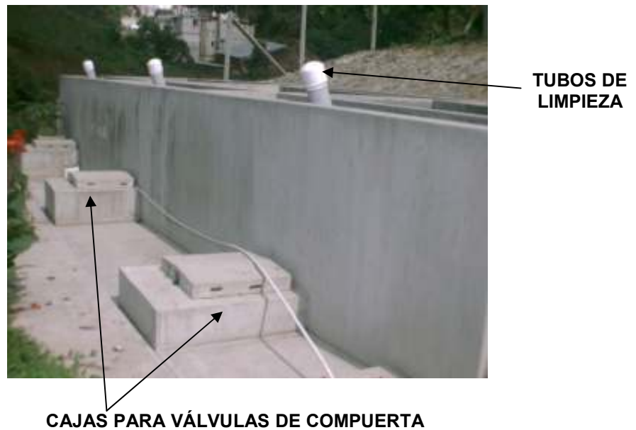
Figura 19. Vista lateral del tanque Imhoff de la planta de tratamiento de aguas residuales de la colonia El Tesoro, Mixco
