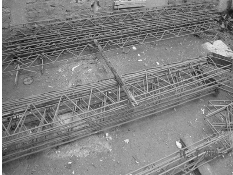
Figura 16 Joist Filigran terminado
