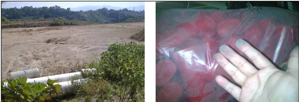
Figura 9. Área en construcción ocasiona contaminación en lugares cercanos
