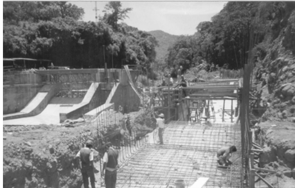
Figura 5. Colocación del Acero de Refuerzo del Canal de Aducción
