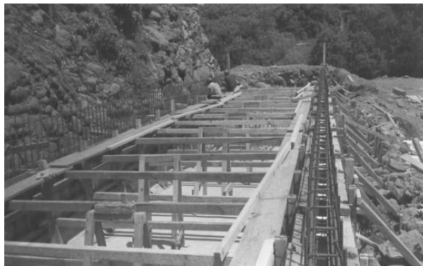
Figura 6. Colocación de formaleta en los muros del canal
