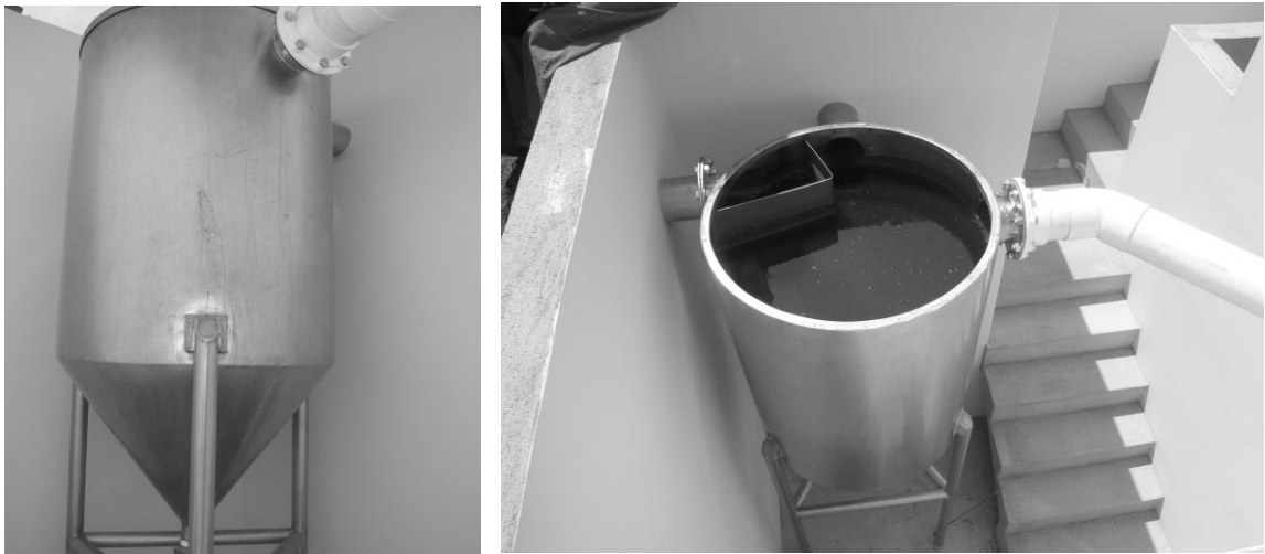
Figura 4. Desarenador de flujo horizontal
