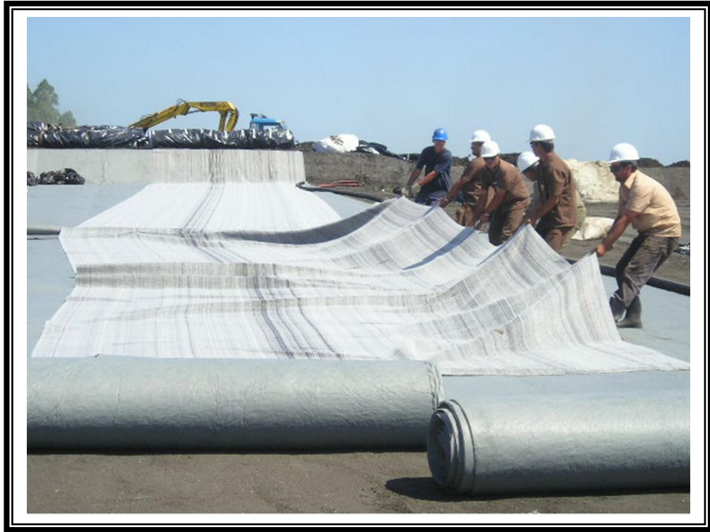
Figura 35. Impermeabilización de relleno sanitario
