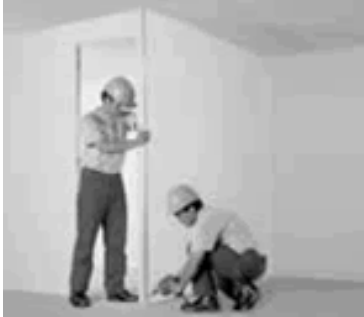
Figura 13. Montaje en esquina
