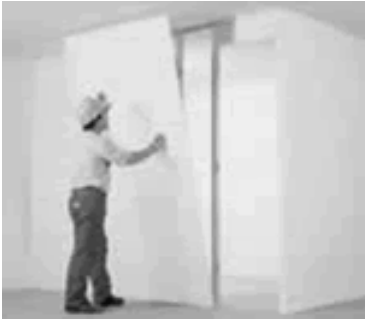
Figura 15. Colocación del panel
