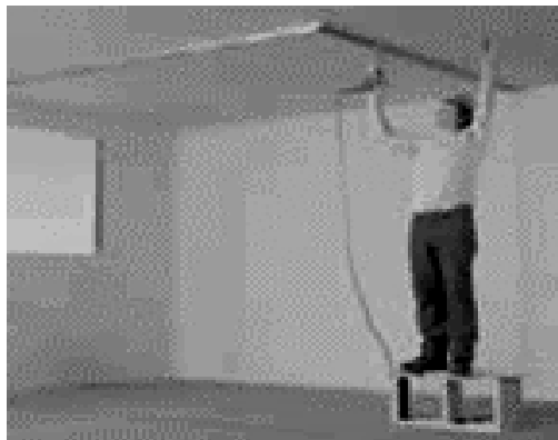
Figura 10. Instalación de canal superior
