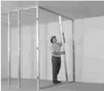
Figura 11. Colocación de poste Fuente: Banquetzal, zona 12.
