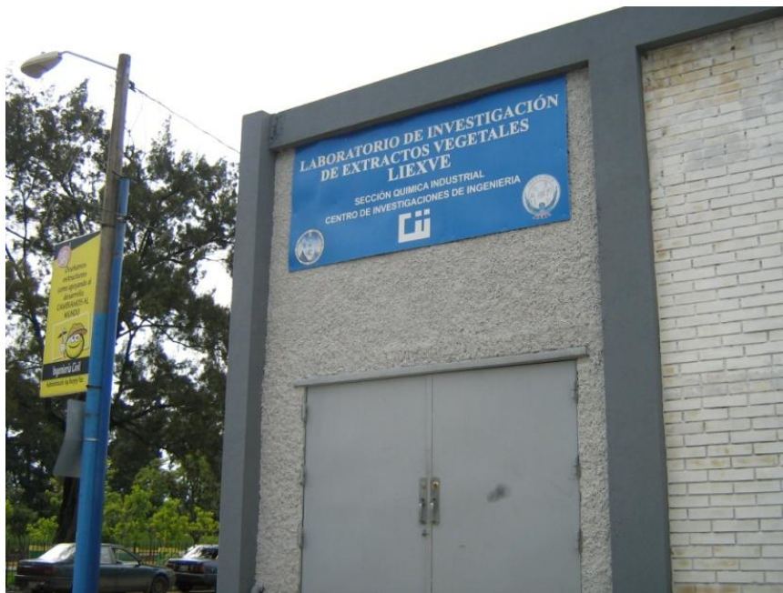
Figura 8. Planta Piloto de Extracción Destilación
