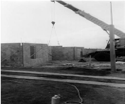
Fuente: C.V. Proyectos S.A. Proyecto habitacional Prado Alto
