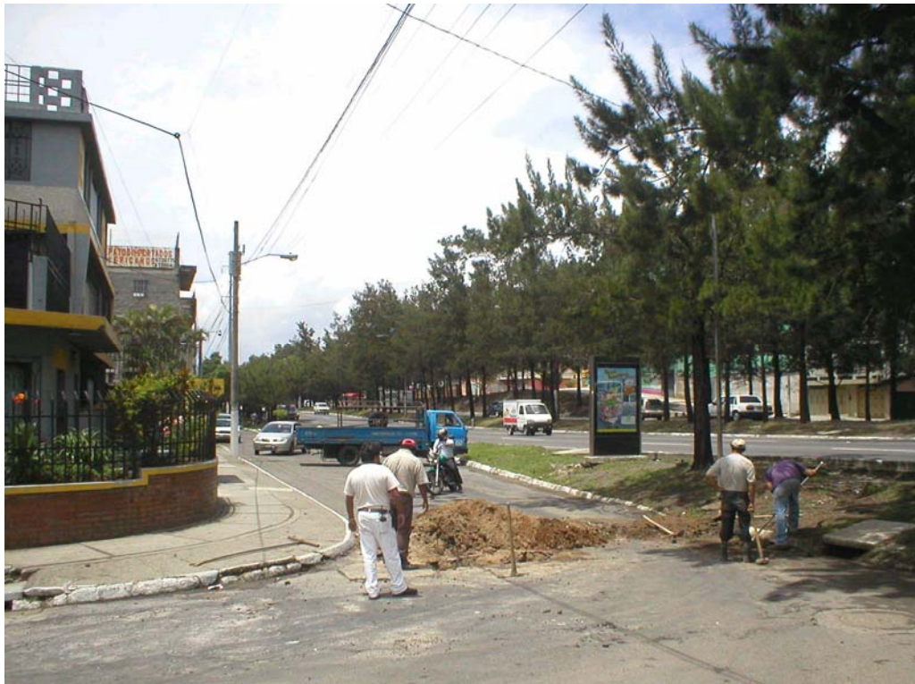
Figura 2. Dificultades de las zanjas
