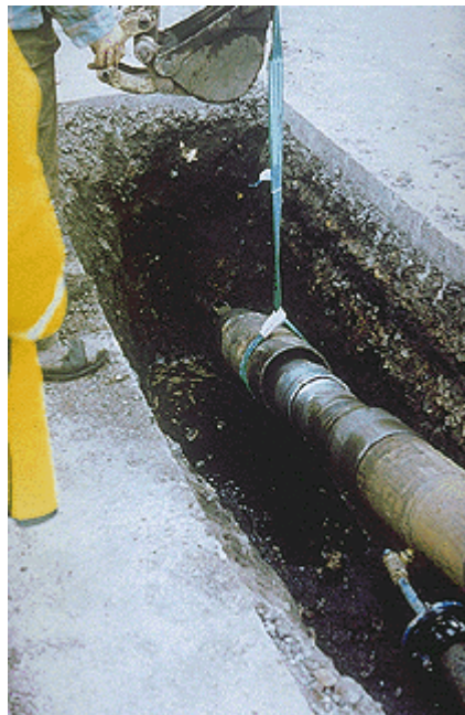
Figura 13. Posicionando una cabeza neumática
