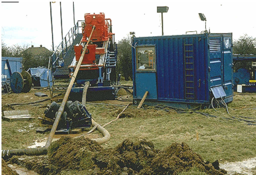
Figura 4. Plataforma de perforación dirigida
