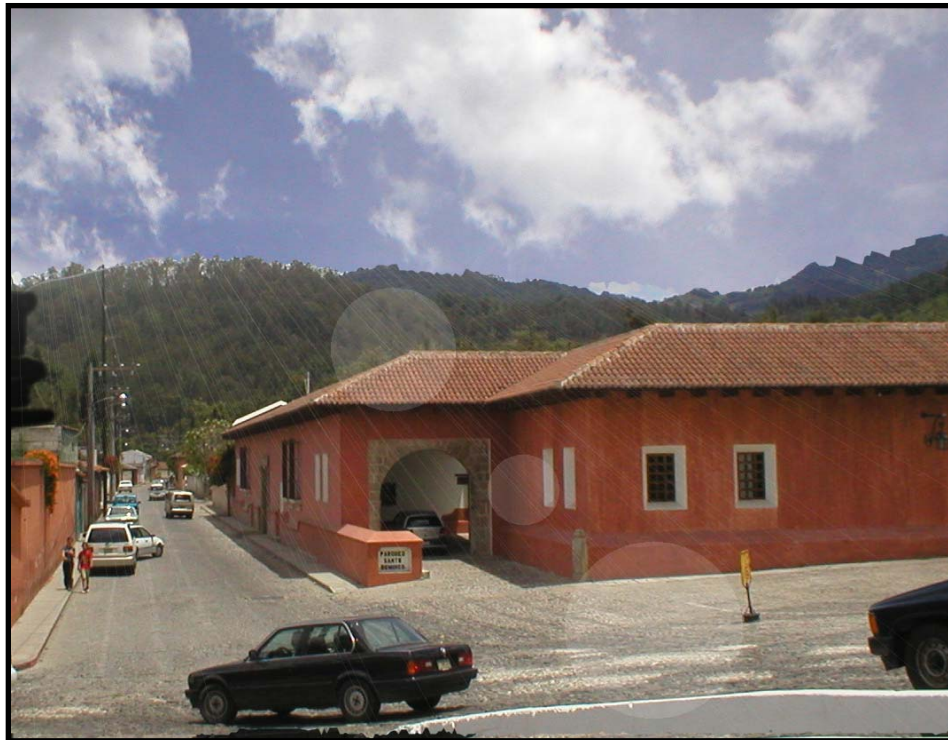
Figura 34. Entrada a la ciudad de Antigua Guatemala sin cables
