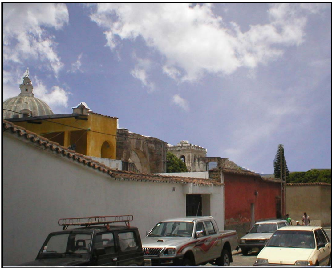
Figura 36. Iglesia de San Francisco, sin cables
