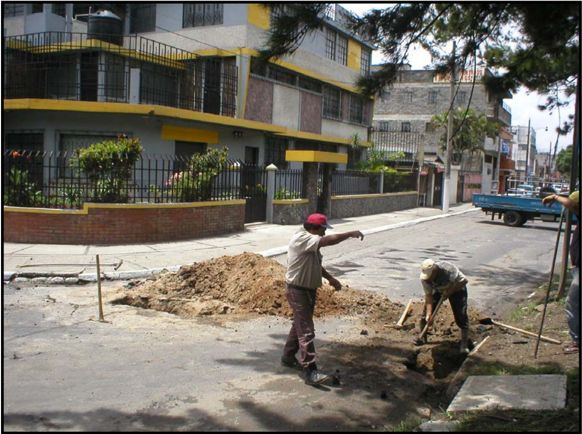
Figura 38. Trabajadores municipales realizando Zanjas
