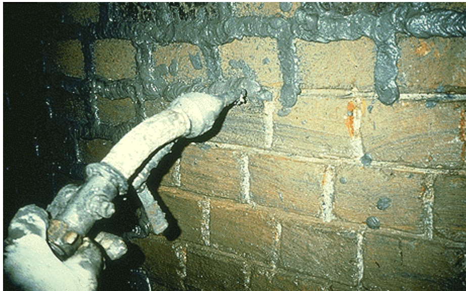
Figura 33. Reparación puntual
