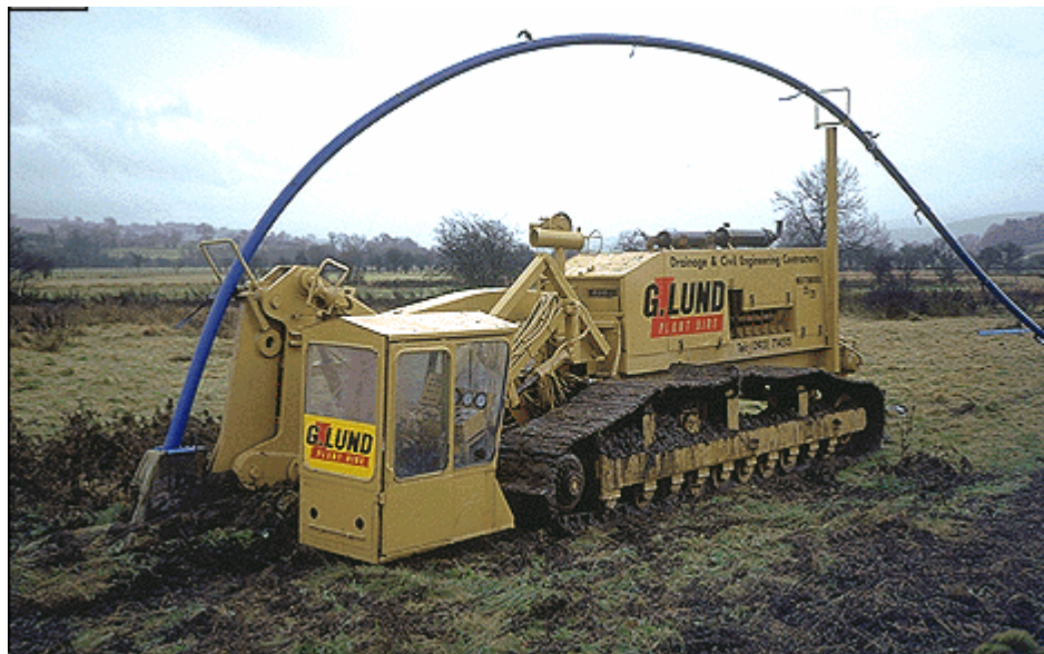
Figura 7. Instalación en el surco
