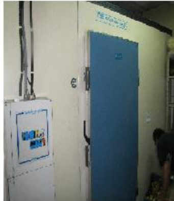
Figura 75. Tuberías del refrigerador
