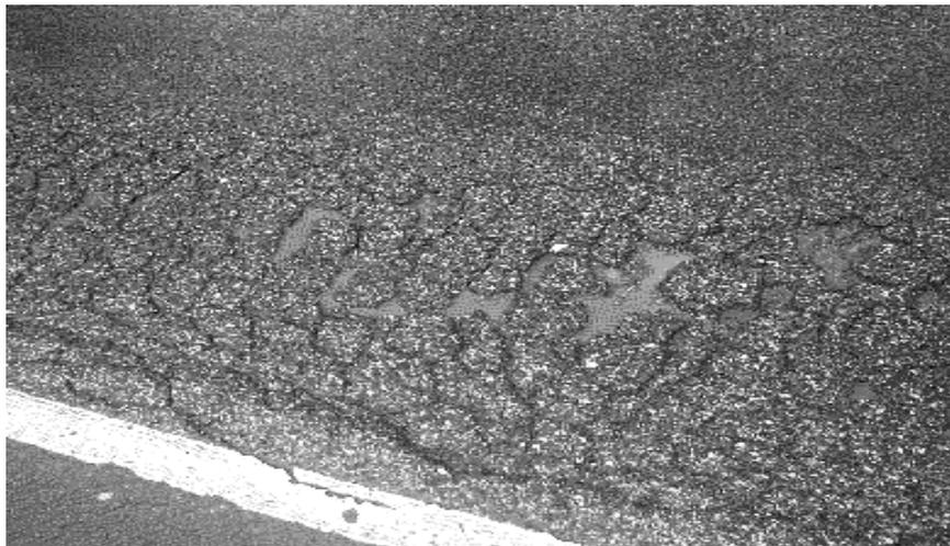
Estas fisuras son causadas por la fatiga de las capas de asfalto al ser sometidas repetidamente a la acción de cargas. Existen tres tipos de severidad: bajo, mediano, y alto.
