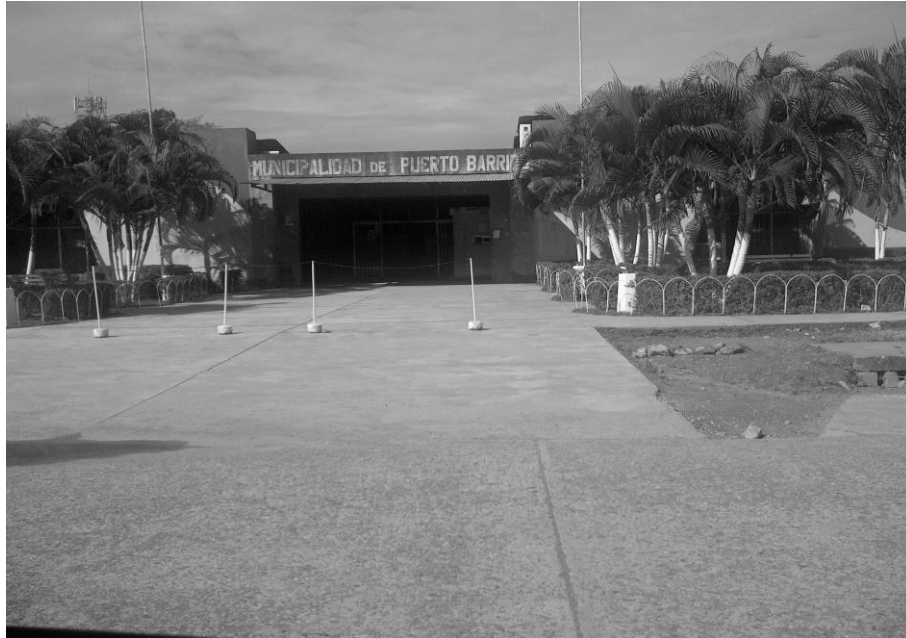
Figura 3. Municipalidad de Puerto Barrios, Izabal
