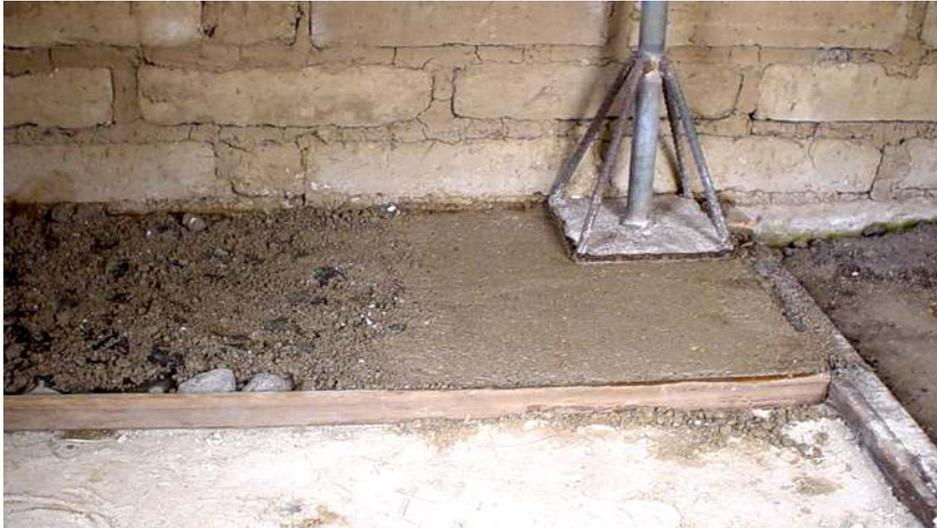
**Figura 6. Compactación de la capa final del piso**
