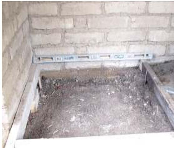
**Figura 11. Capas de material para elaborar el piso a base de tierra**
