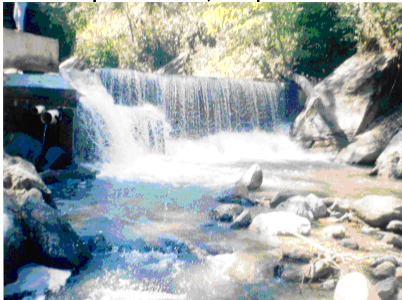
Figura 11. Presa de la captación de agua del sistema de abastecimiento de agua potable del municipio de Gualán, Zacapa
