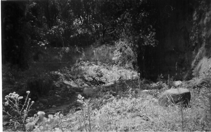
FIGURA 19. Vista previa construcción del dique.
