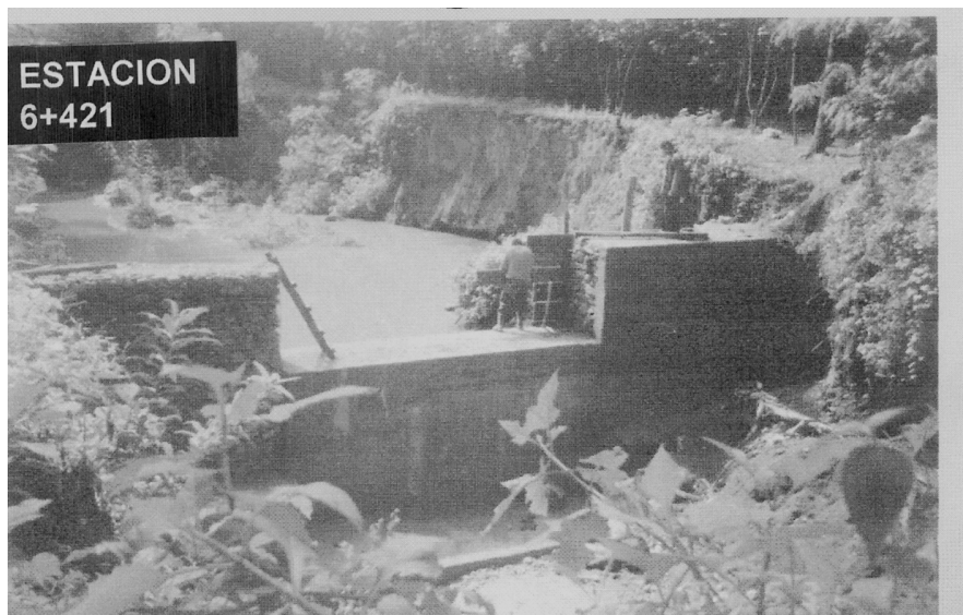
FIGURA 20. Vista durante construcción del dique.
