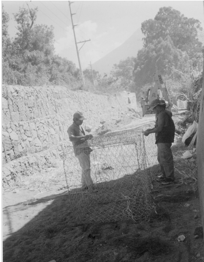
FIGURA 6. Armado de canasta en campo.
