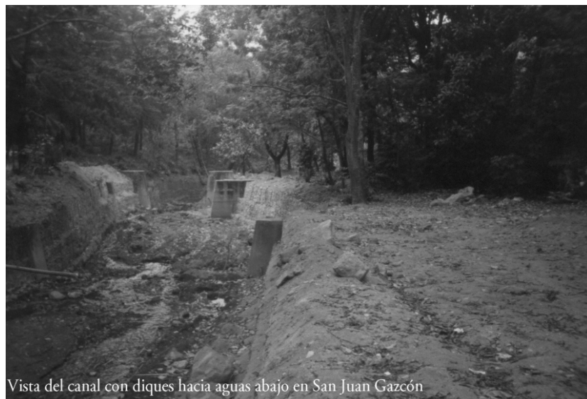
FIGURA 16. Sección de canal; al fondo se observa el dique.
