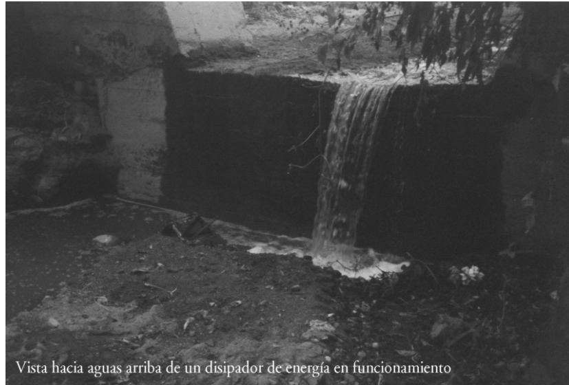
FIGURA 15. Disipador de energía en funcionamiento.
