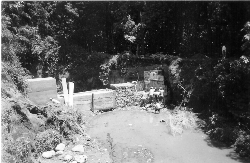
FIGURA 21. Vista antes de cerrar el dique; ver el nivel del sedimento.
