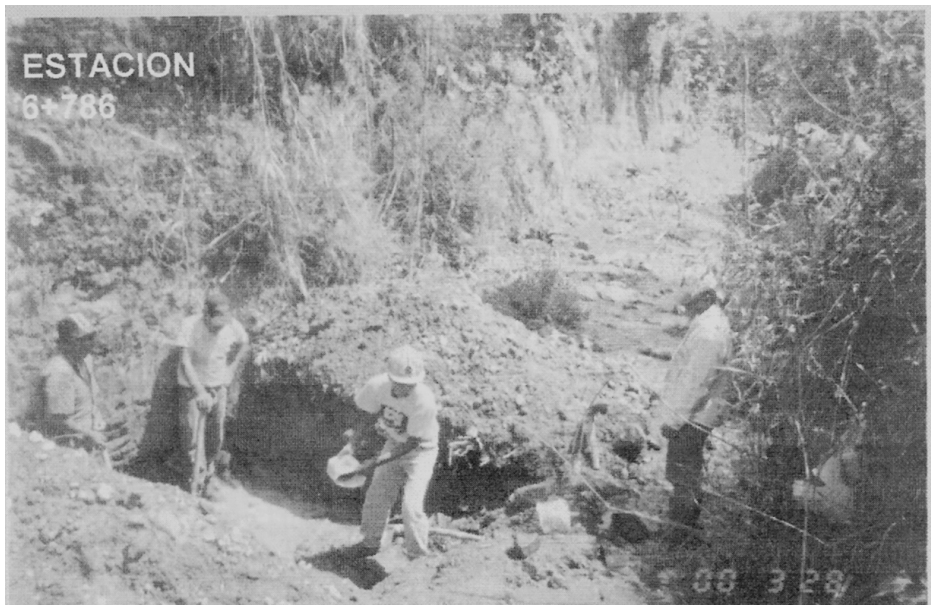
FIGURA 12. Excavación para cimentación y dissipador de energía.
