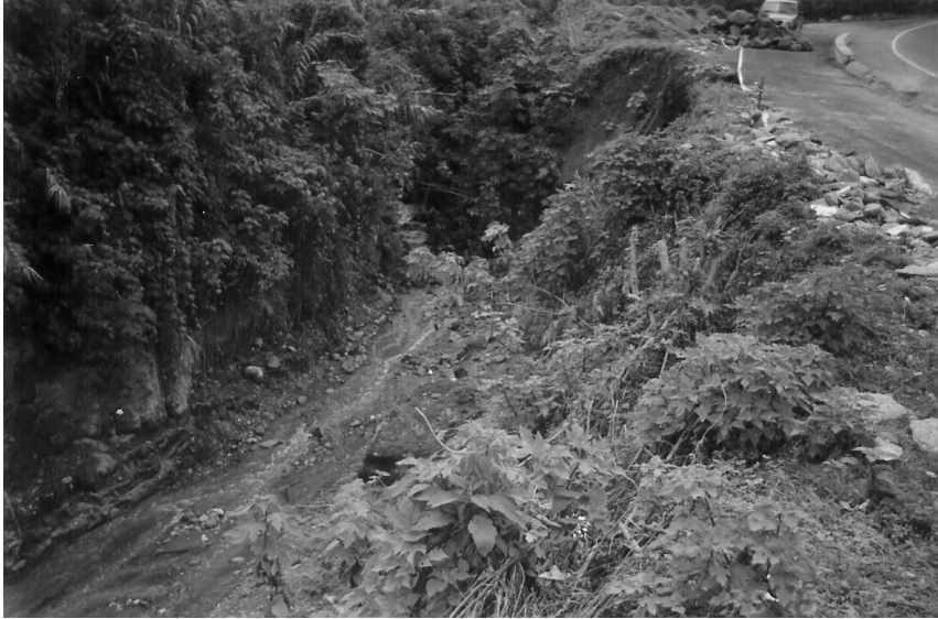
FIGURA 17. Vista previa construcción del dique y el muro.
