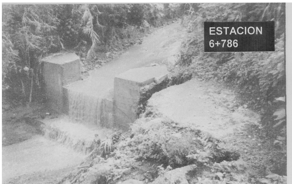
FIGURA 14. Dique construido en funcionamiento.
