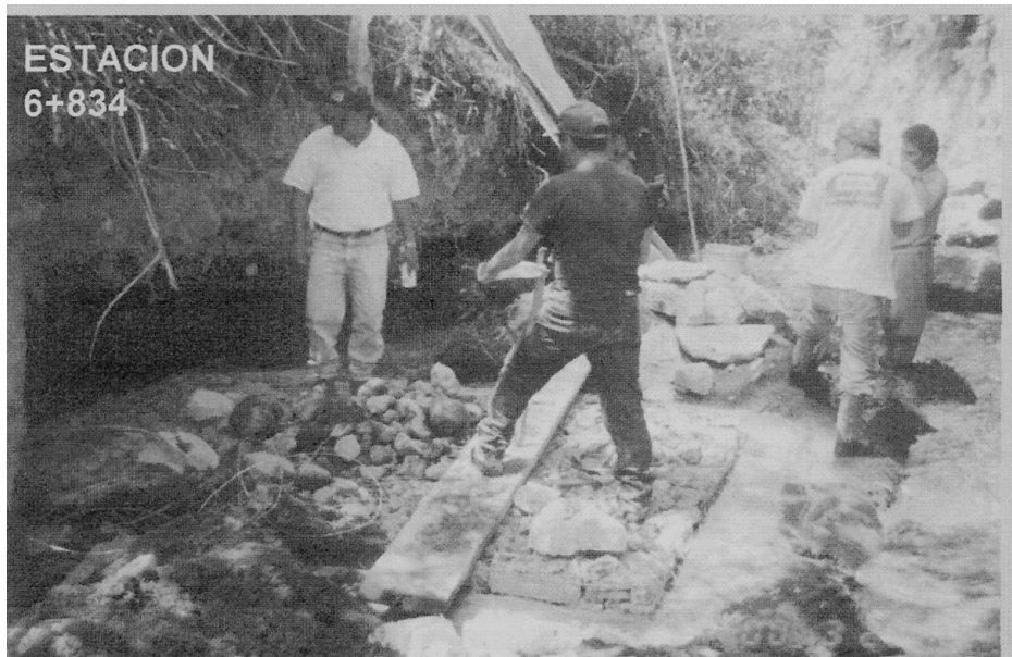
FIGURA 13. Construcción de cimiento y dissipador de energía.
