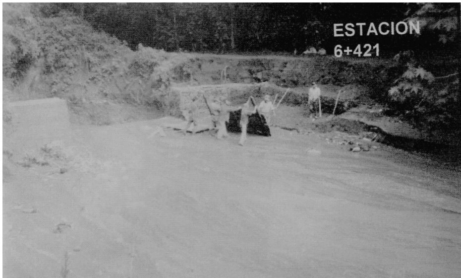
FIGURA 22. Vista luego de cerrar el dique; el nivel del sedimento llega al vertedero.
