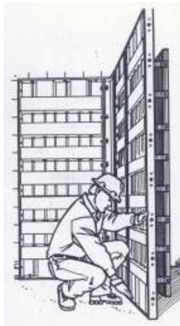
Figura 4. Paneles de la formaleta de aluminio para los muros
