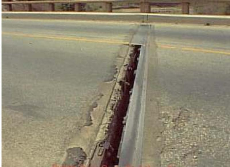
**Figura 15. Falla del anclaje de junta en pila de puente Francisco Marroquin
