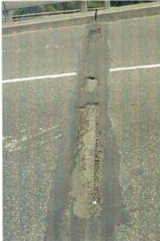
El deterioro de las juntas ahogadas comienza con una grieta de pelo que se forma en la capa de asfalto de rodadura, la cual usualmente se localiza a lo largo de la abertura de expansión de las juntas. Con el transcurso del tiempo aumenta el deterioro, produciéndose el agrietamiento múltiple y formándose baches. Al estar la superficie de rodadura en estas condiciones es mayor el riesgo de que haya filtración de agua a la subestructura.
