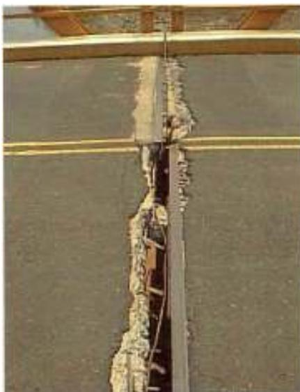
En una investigación realizada por Black sobre juntas de expansión de puentes en servicio en Gran Bretaña, se determinó que la causa principal de la falla de las juntas era debido a deficiencias en el sistema de anclaje. La falla en el sistema de anclaje con barras se produce especialmente bajo cargas pesadas de tráfico y puede darse por fatiga de la soldadura del anclaje.
