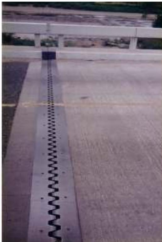
En el caso de las juntas de placa deslizante es especialmente importante que la parte superior de las orillas de las juntas queden a un mismo nivel, para que la placa cubrejunta esté apoyada en forma uniforme a ambos lados de la junta. Si se utiliza este tipo de junta, y además se emplea apoyos de caucho (apoyos de tipo flexible) como sistema de apoyos de la superestructura, según Black, debe tomarse en cuenta las siguientes consideraciones:
