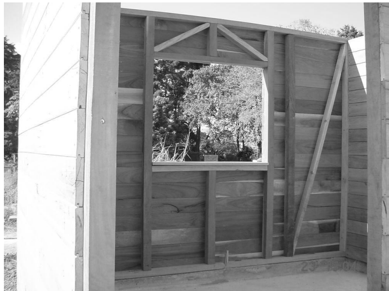
v) Vista interior, estructura de pared
