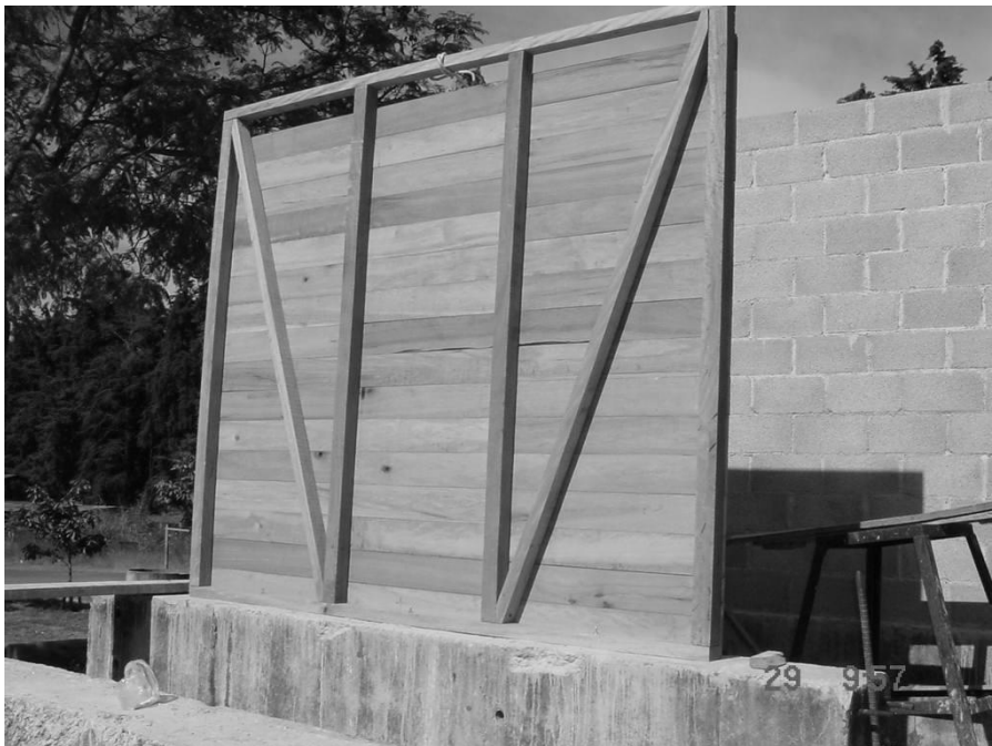
f) Pared montada en viga de ensayo
