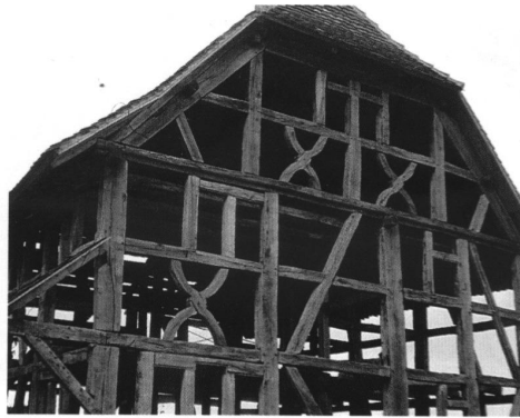
Figura 7. Entramado de elementos cortos
