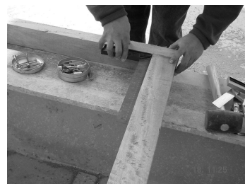
b) Verificación de escuadra
