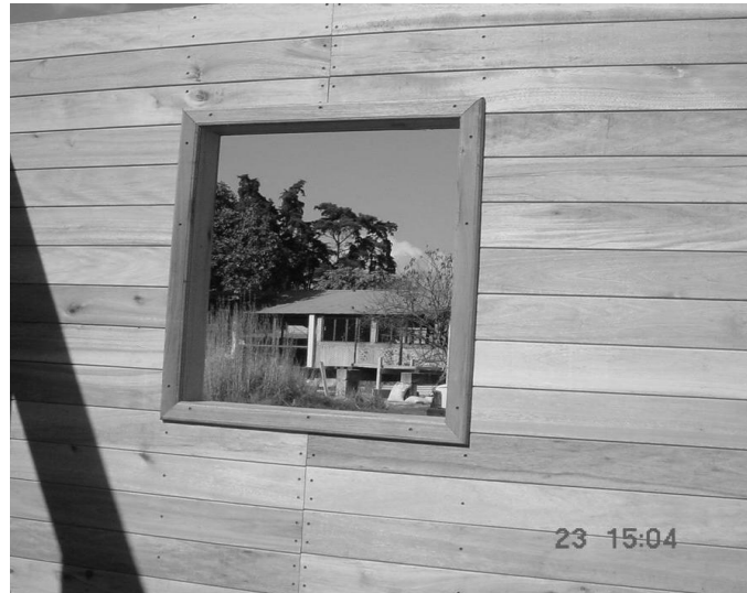
w) Detalle de marco interior en ventana
