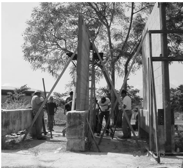
Figura 38. Pared instalada en la viga de ensayo
