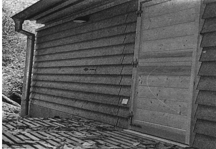
Figura 13. Forro exterior con tabla solapada
