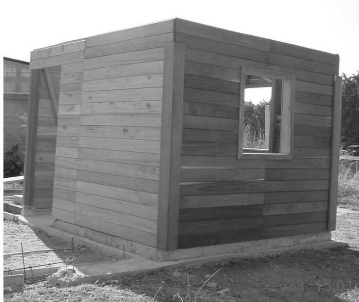
u) Vista frontal del ambiente terminado
