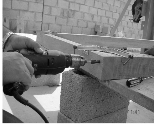
d) Unión con tornillos
