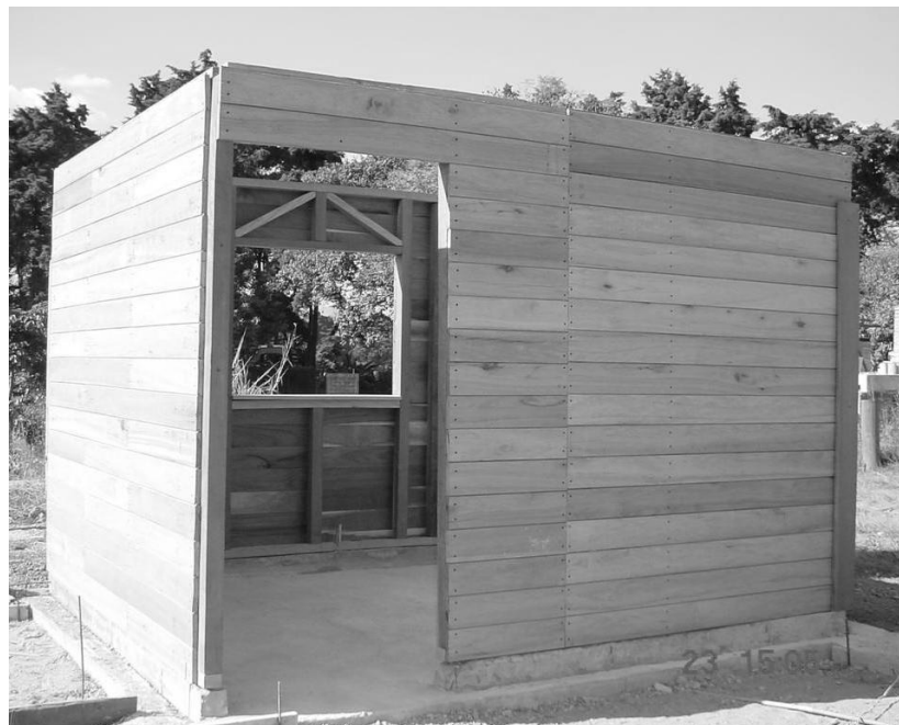
x) Vista de dos paredes interiores con machihembre de Santa María
