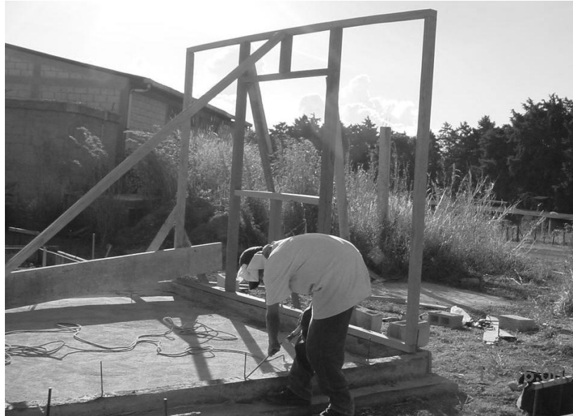
d) Colocación de la estructura en la cimentación
