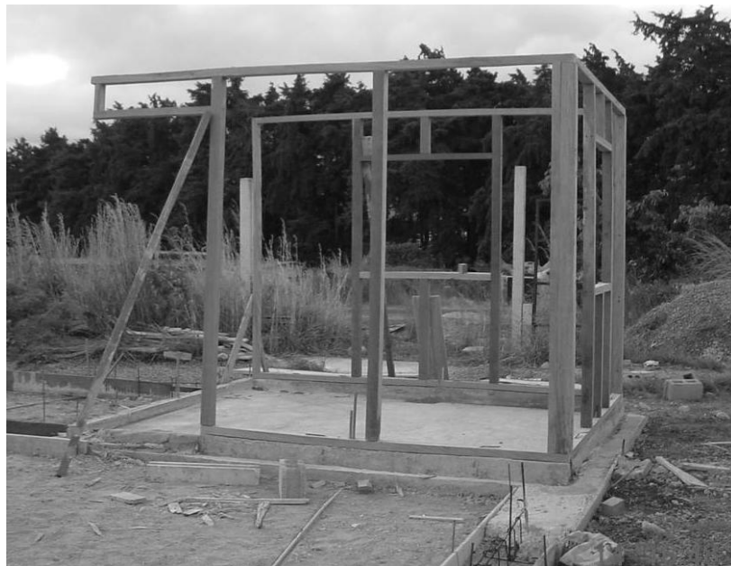
g) Montaje de la estructura de la tercera pared, con vano para puerta
