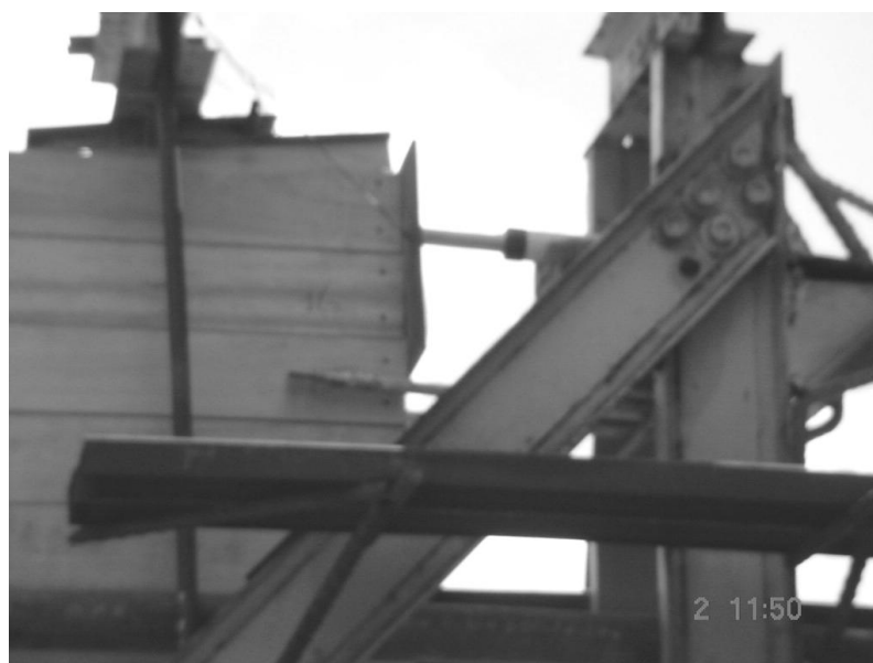
Figura 41. Aplicación de carga lateral
