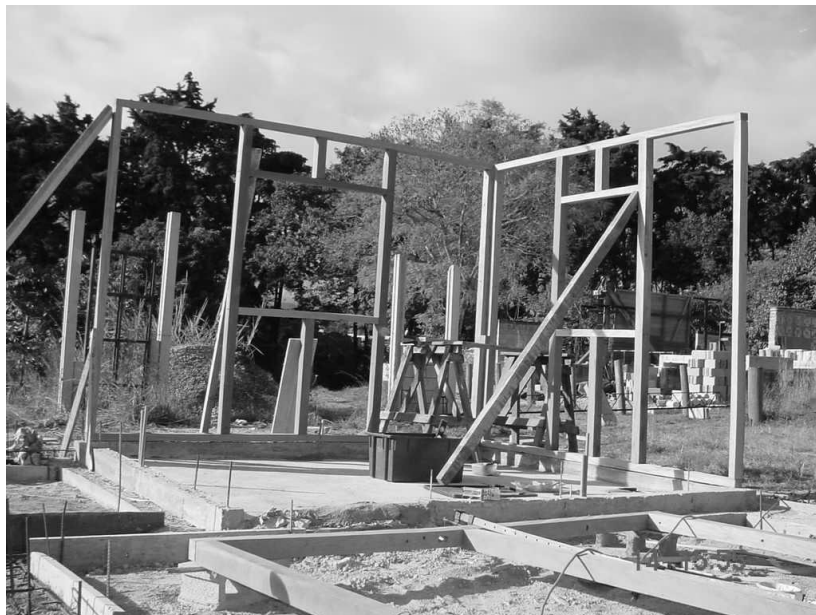
e) Estructura de dos paredes con vanos para ventanas
