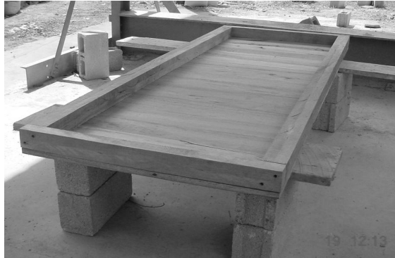
h) Instalado forro machihembrado en una cara
