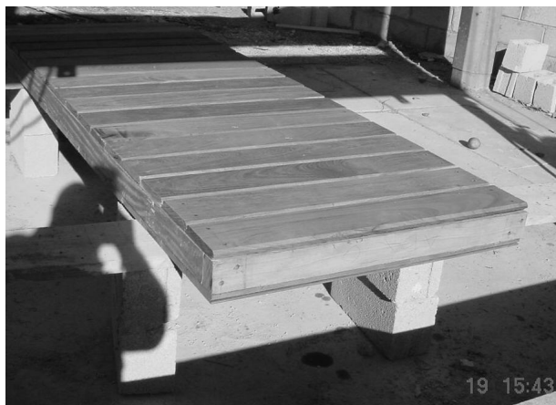
k) Pared terminada con doble forro
