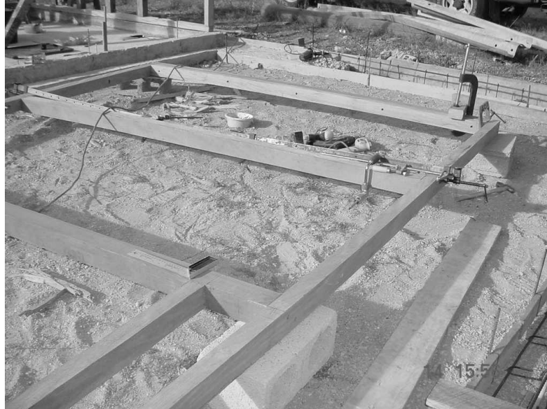
g) Montaje de la estructura de la tercera pared, con vano para puerta
