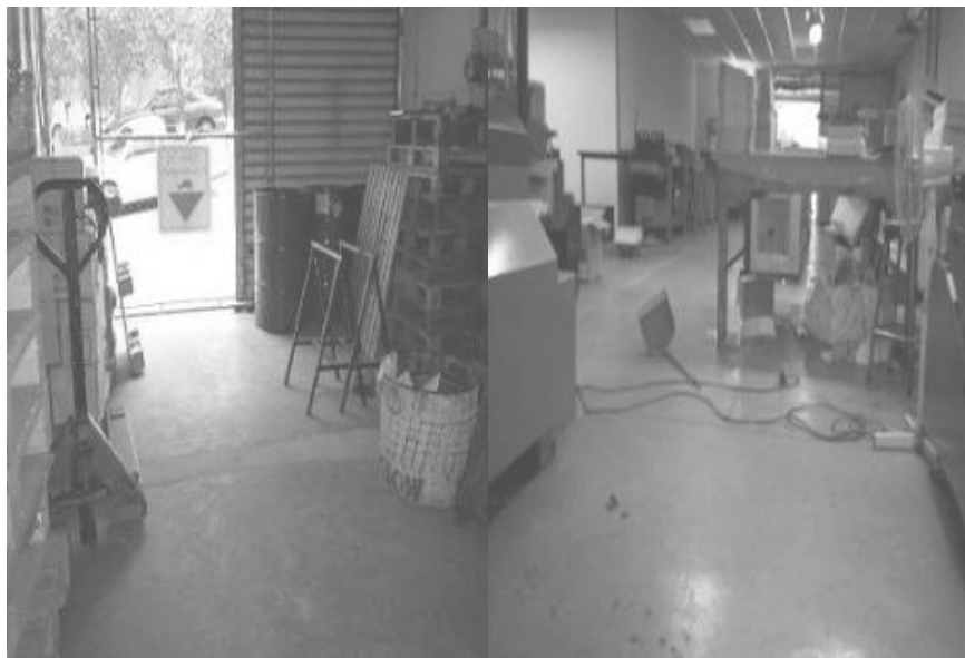
Figura 40. Obstrucción de corredores y puertas
