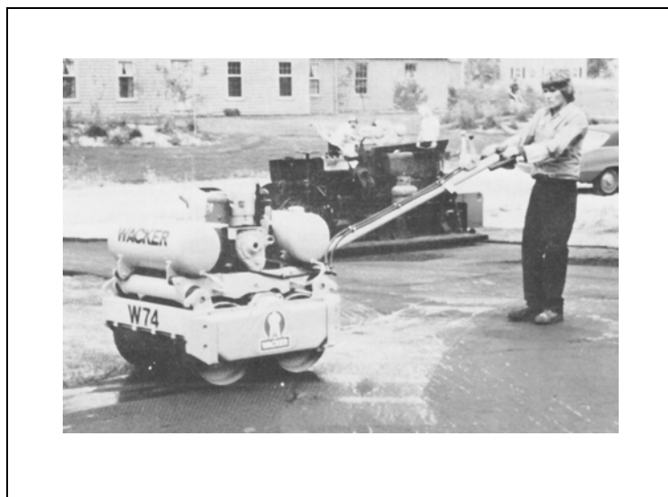
Figura 18. Rodillo W 74T usado para compactar asfalto.
