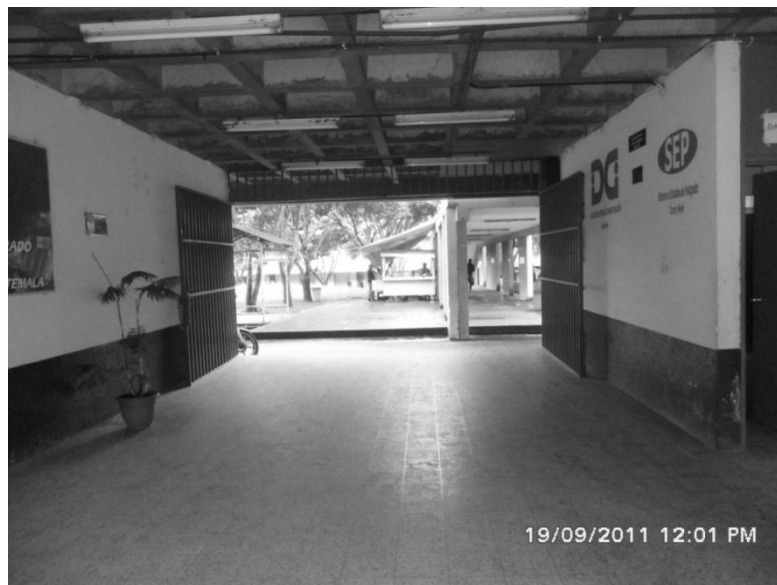
Figura 20. Puerta principal de acceso al edificio S11
