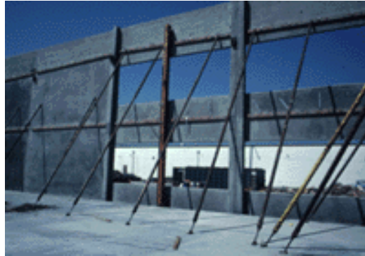
Figura 9. Soportes deteniendo los paneles, antes de la fijación final.
