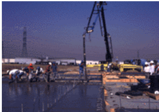
Figura 6. Fundición de paneles por medio de un camión bomba.
