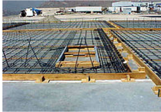
Figura 4. Colocación de refuerzo estructural aprovechando el perímetro de la obra.
