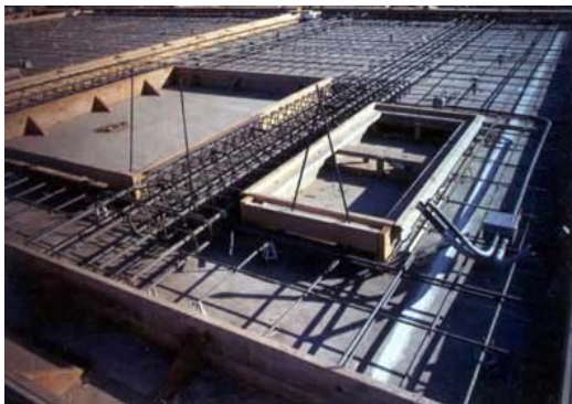
Figura 3. Encofrado y refuerzo para ventanería y puertas.
