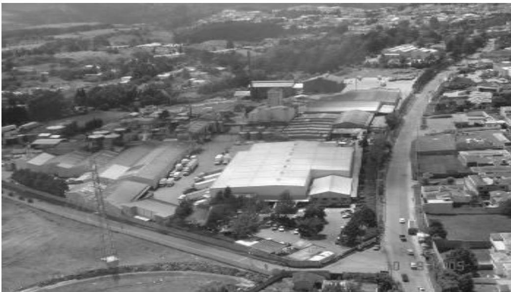
Figura 1. Vista aérea del centro de distribución
