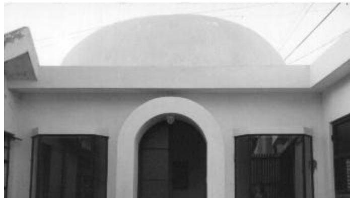
Figura 37 Bóveda construida de ferrocemento con acabados
