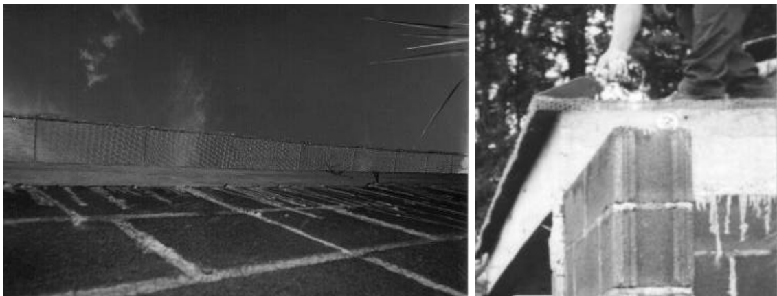
Figura 46 Construcción de la gota del techo
