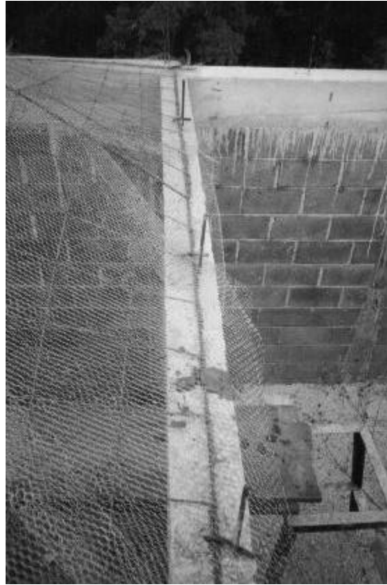
Figura 31 Fijación del bastidor a muros
