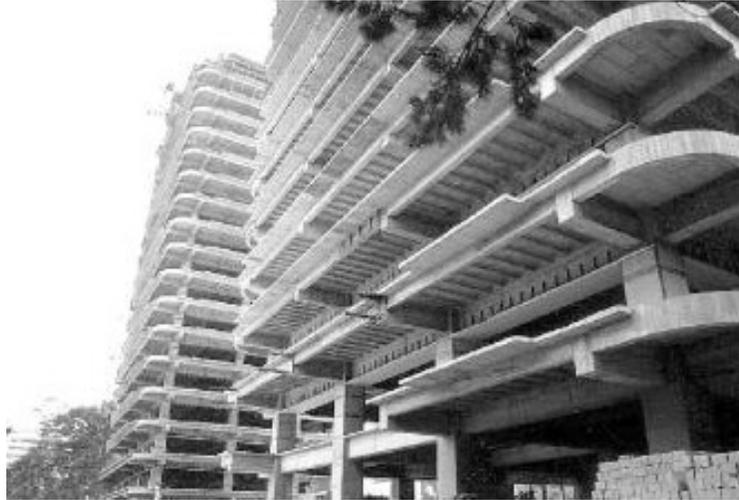
En obra, luego de que usted coloca las vigüetas y el molde LK entre las mismas, colocará el refuerzo de topping, siendo este un acero de alta resistencia o acero tradicional diseñado según la luz de la losa, colocándose bastones para absorber el momento negativo.
