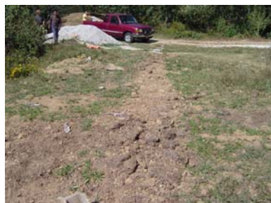
Figura XXV. Zanja de tubería de entrada
