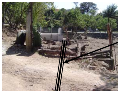
Figura XXIV. Zanja de tubería de salida
