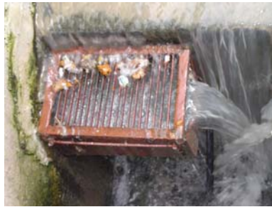
Figura IV. Obra de captación
