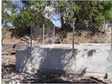
Figura XXVI. Tubos para la puesta de malla
