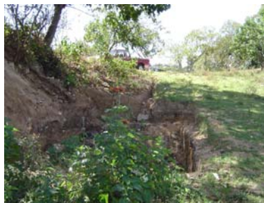
Figura XXII. Área en la que se excavó inicialmente
