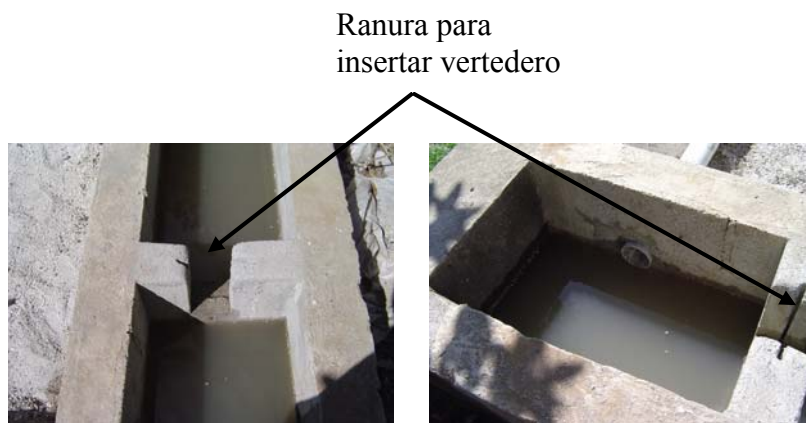
Figura XXXI. Ranura donde se colocó vertedero
