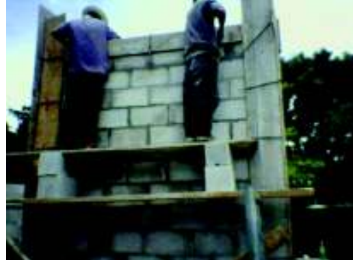
Muro a corte a escala natural
