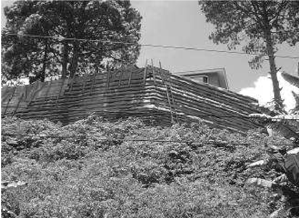
Fotografía 6: Proceso de Construcción finalizado e incorporado a la Residencia
