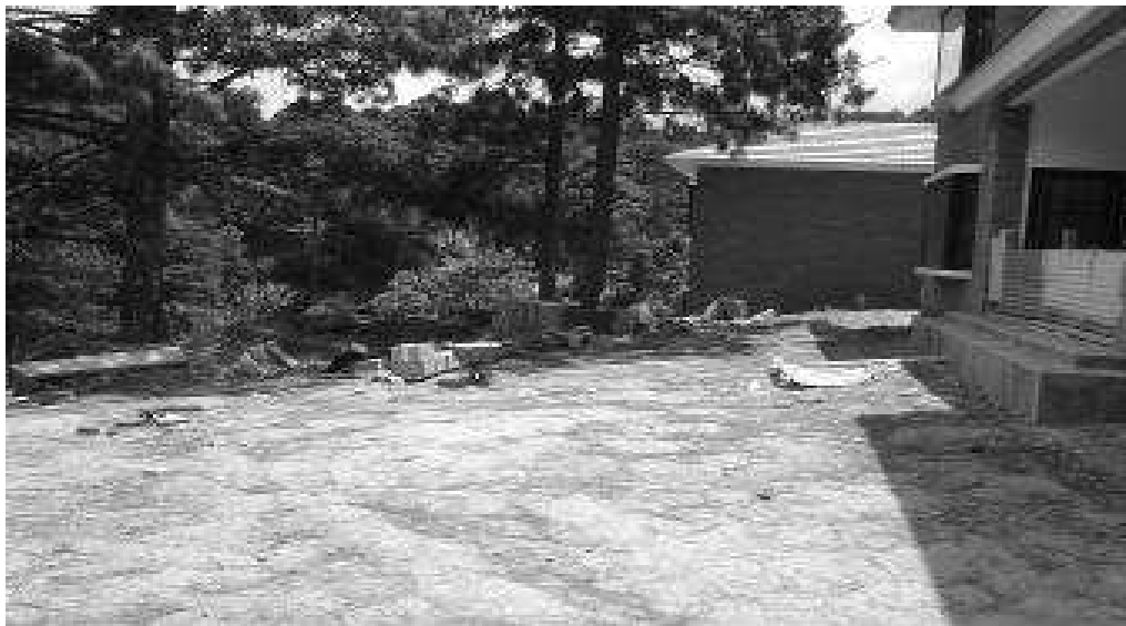
Fotografía 5: Proceso de Construcción un mes después de iniciados los trabajos
