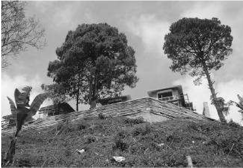
Fotografía 4: Vista muro terminado
