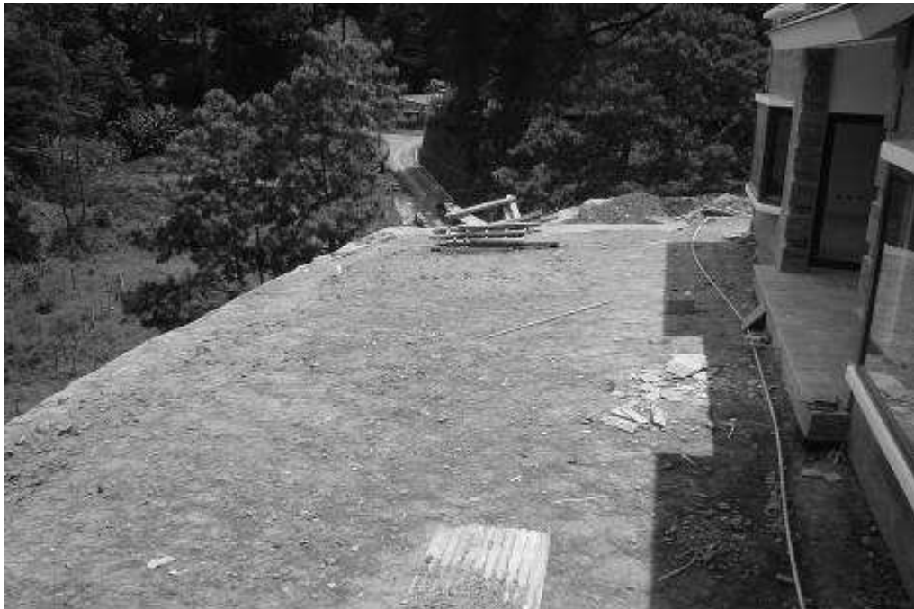
Fotografía 1: Espacio en muro terminado.
