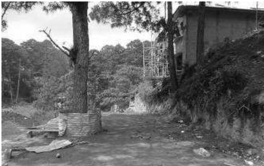
Fotografía 3: Proceso de Construcción durante la primera semana de trabajo
