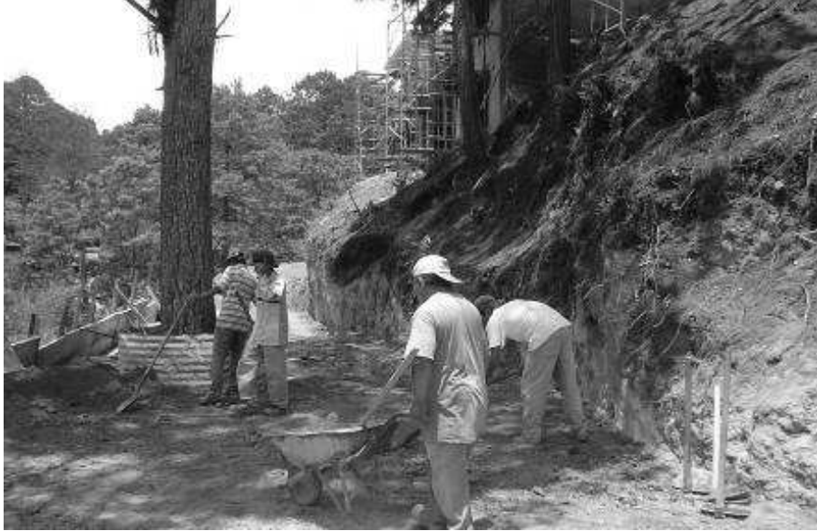
Fotografía 2: Muro en Suelo Reforzado existente en la zona del Proyecto
