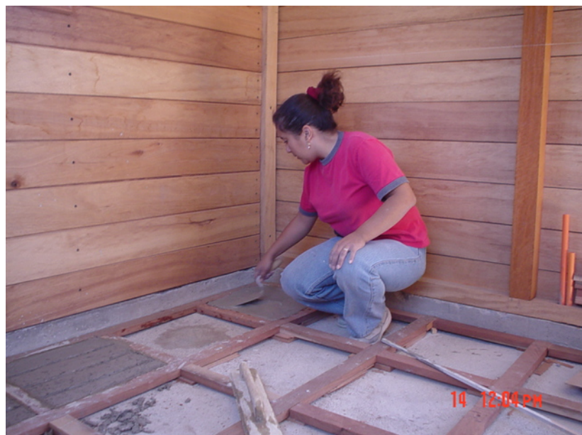
Figura 22. Fundición para relleno entre cada cuadro de las vigas
