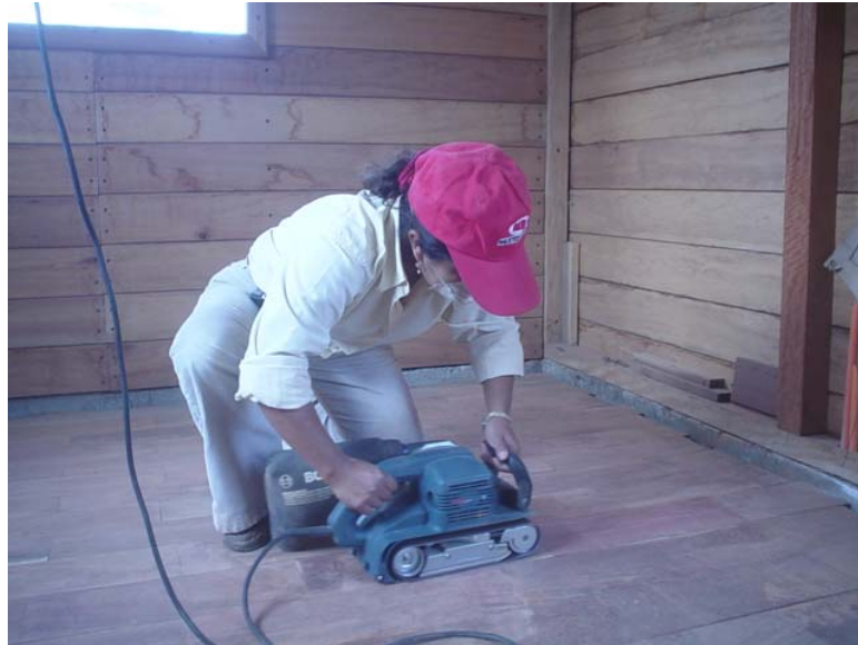
Figura 24. Proceso de pulido
