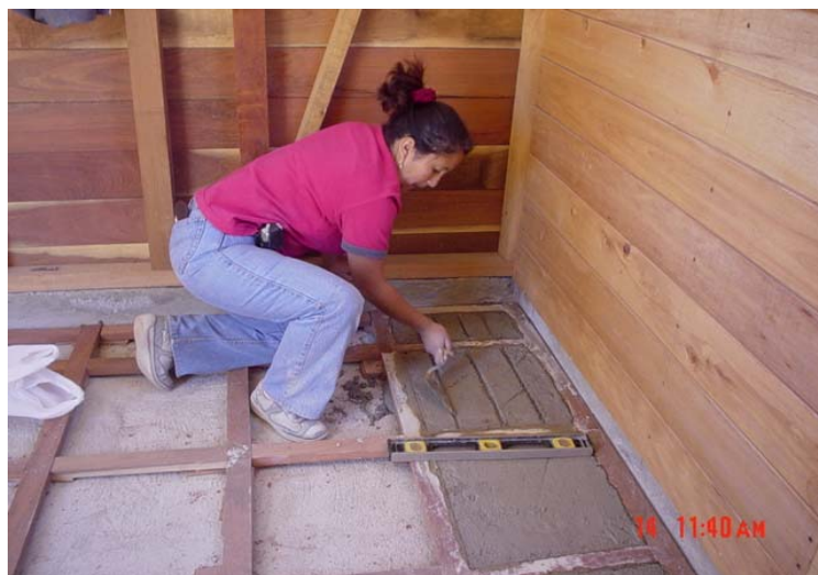
Figura 12. Relleno de las vigas con cemento y cal con sisa para la ventilación Interna del piso
