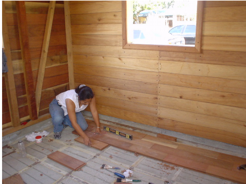
Figura 23. Colocación del parquet tipo entablonado
