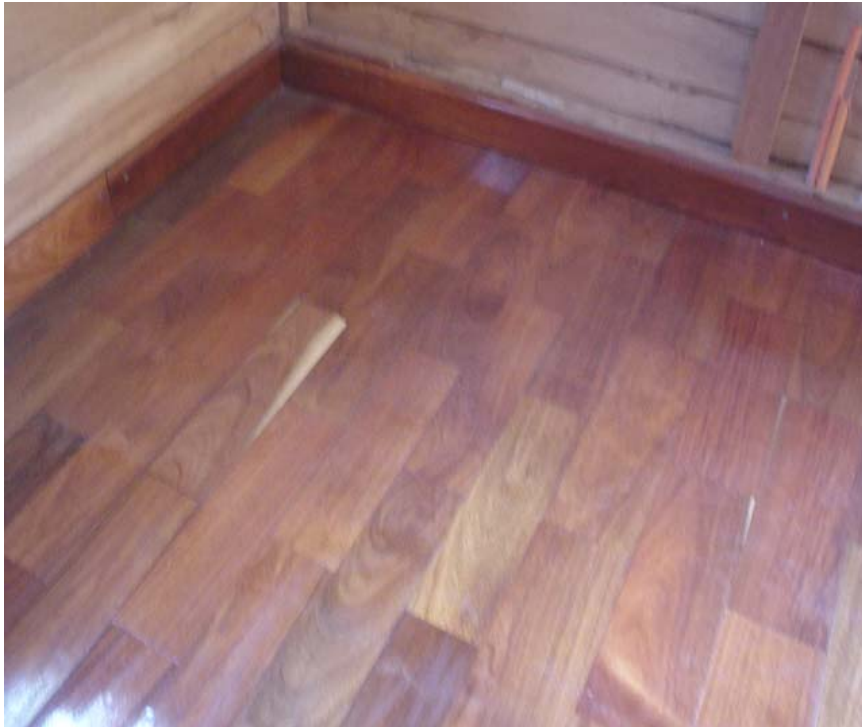
Figura 25. Parquet pulido y acabado de poliuretano
