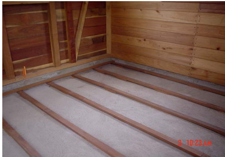
Figura 11. Vigas primarias para parquet
