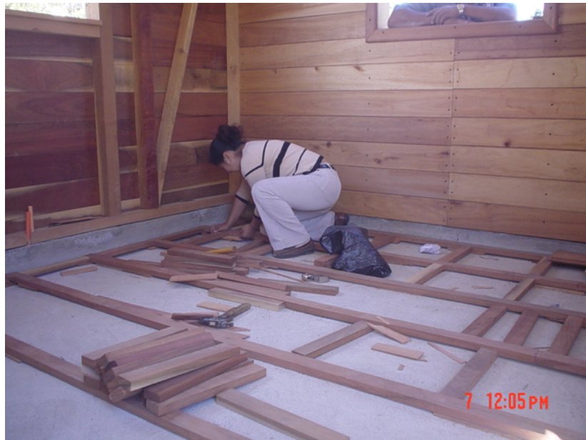
Figura 21. Armado de vigas primarias y secundarias
