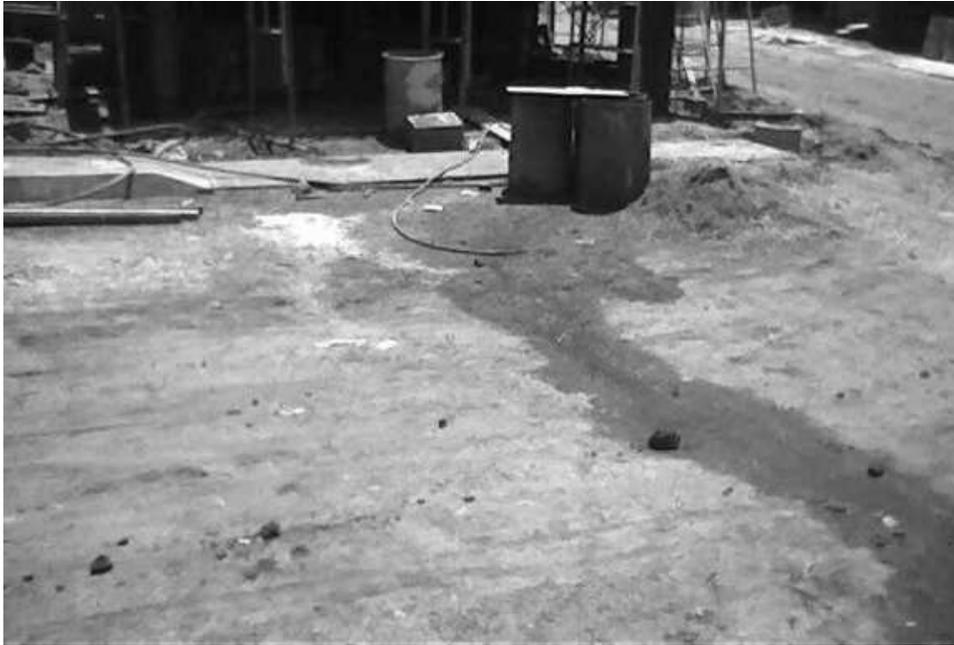
**Fotografía 12 Contaminación de pavimento por residuos.**
