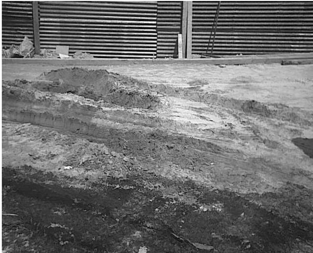
**Fotografía 5 Imprimación dañada por circulación de vehículos.**
