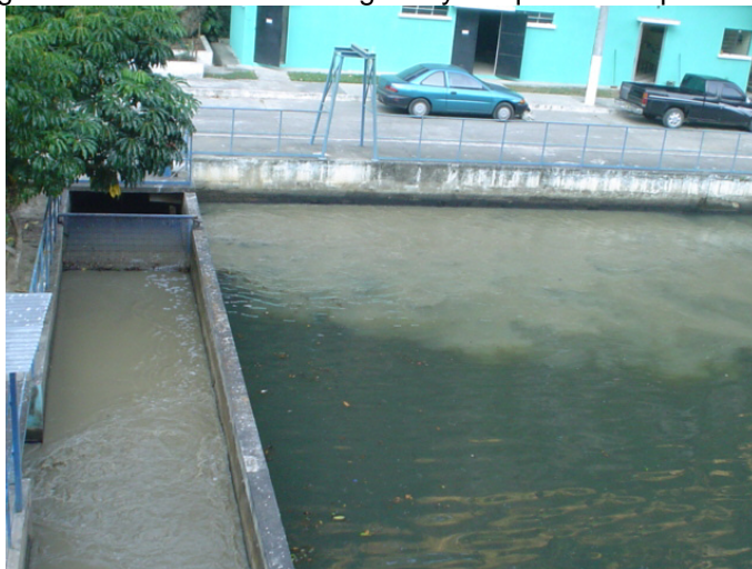
Figura 6. Desarenador rectangular y tanque de compensación
