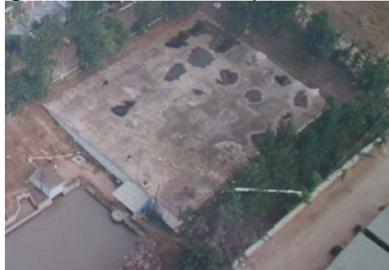
Figura 23. Panorámica del tanque semienterrado
