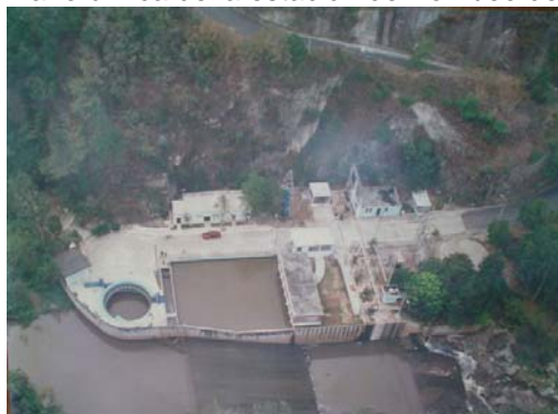
Figura 2. Panorámica de la estación de Bombeo del Atlántico
