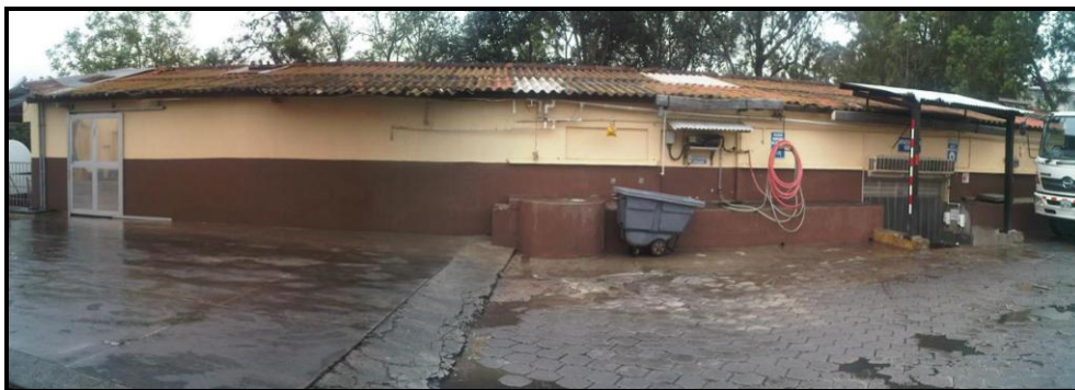
Figura 83. Vista panorámica instalaciones producción de verduras
