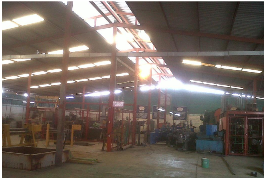
Figura 40. Interior de planta
