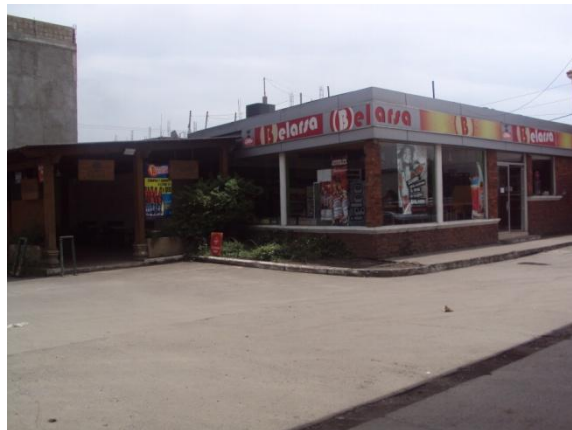
Figura 2. Instalaciones de Estación Belarsa
