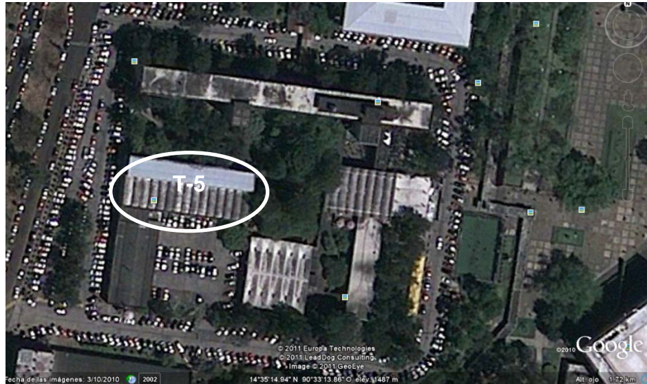
Figura 8. Vista de las instalaciones del edificio T-5 de la FIUSAC
