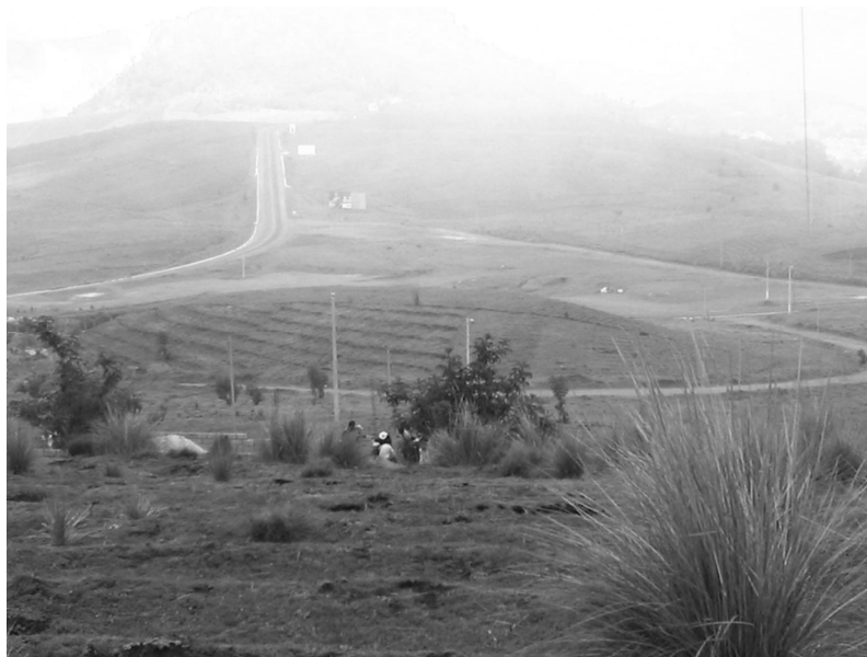
Fotografía 1. Sitio de la construcción de torre, Santa Catarina Ixtahuacán
