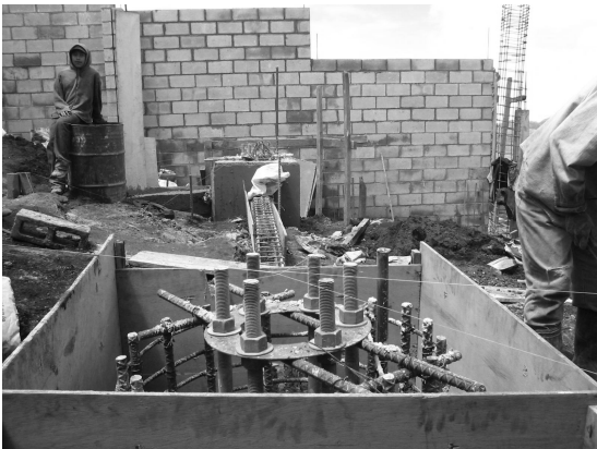
Fotografía 6. Fundición de cimiento
