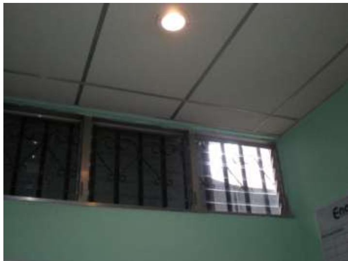
Figura 5. Iluminaria de área de almacenaje
