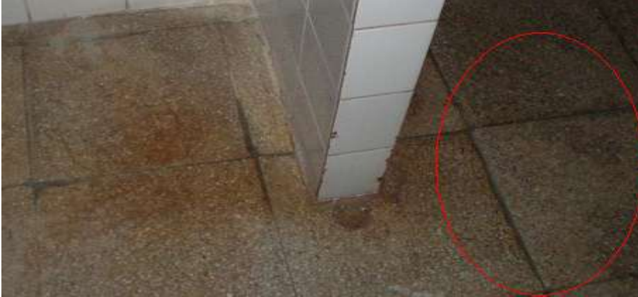
Figura 6. Piso de área de lavado
