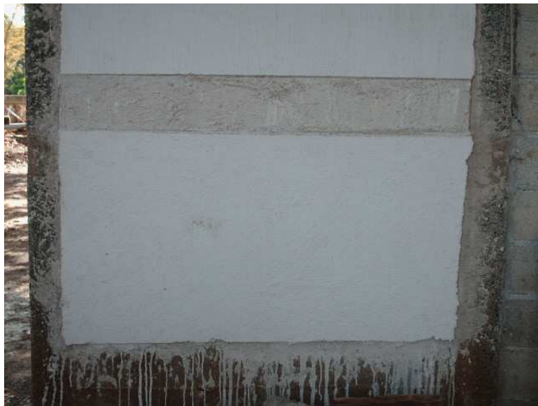
Figura 10. Aplicación de mortero de revestimiento, acabado remolineado
