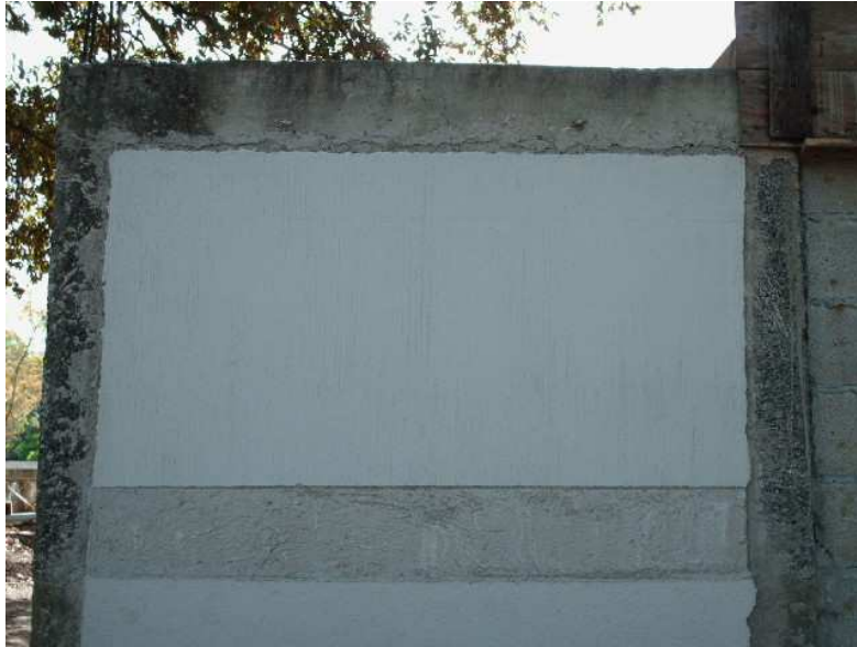
Figura 9. Aplicación de mortero de revestimiento, acabado vertical
