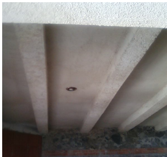
Figura 15. Inspección de cielos. Cielo de casa particular
