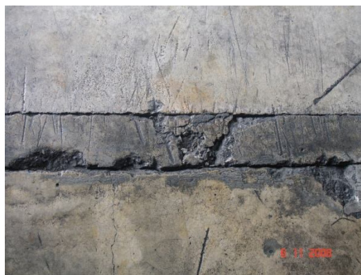
Figura 13. Inspección en piso. Planta procesadora de galletas
