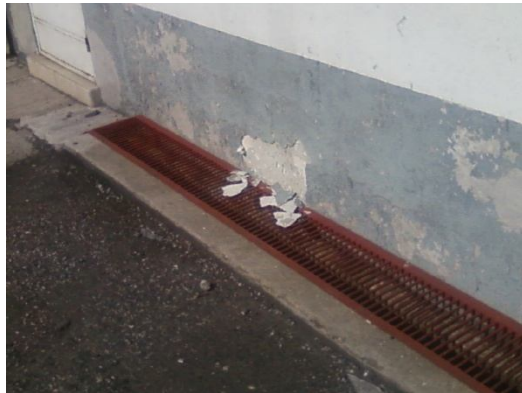
Figura 12. Inspección en paredes. Paredes planta de procesamiento de jabón
