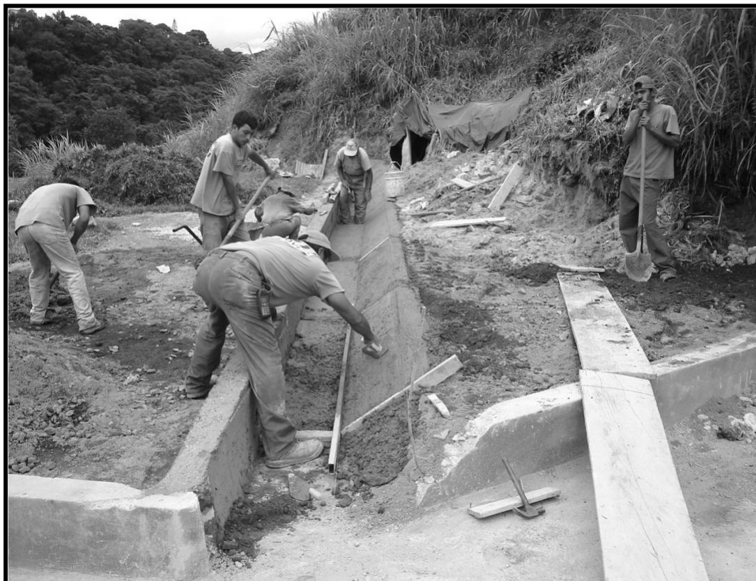
Figura 24. Construcción de cunetas y bordillos
