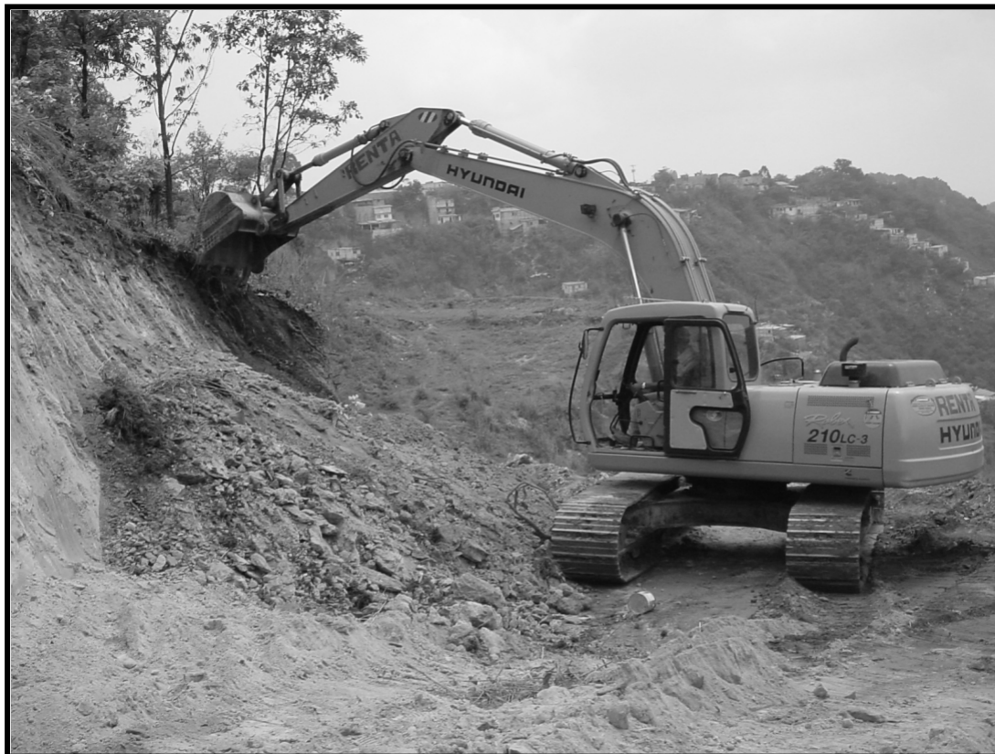
Figura 2. Excavadora de banda
