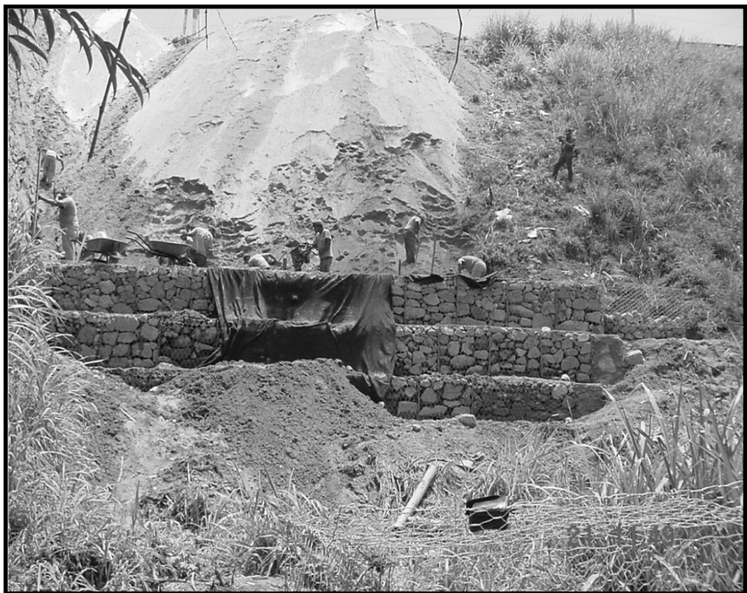
Figura 16. Construcción de muro de gaviones
