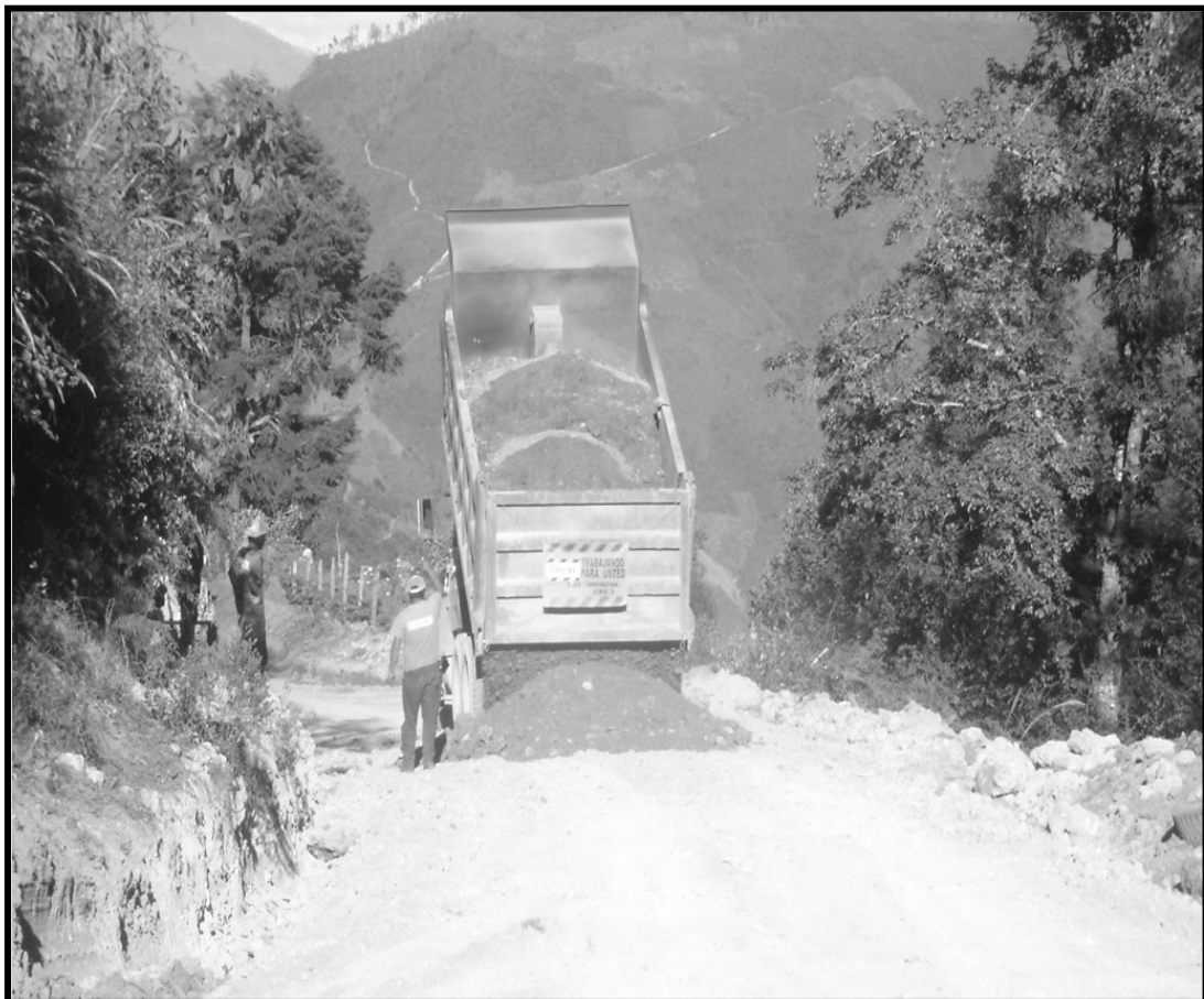
Figura 6. Camión de volteo
