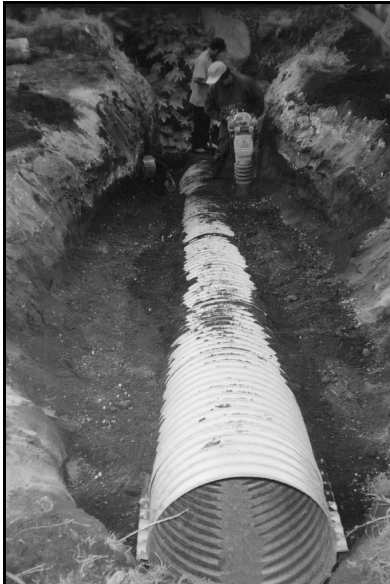
Figura 21. Colocación de alcantarilla de metal
