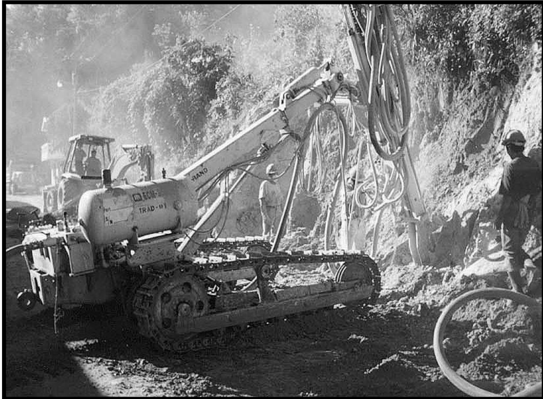
Figura 15. Barrenación con track-drill para uso de explosivos
