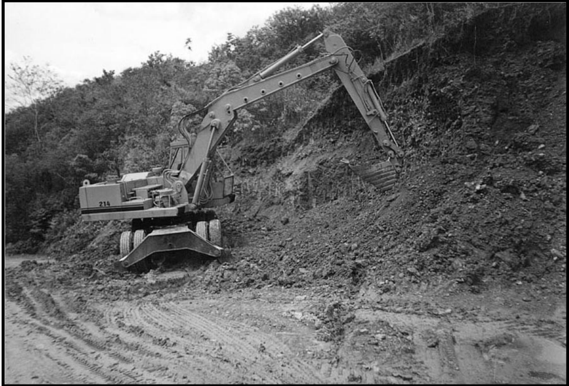
Figura 3. Excavadora de llanta
