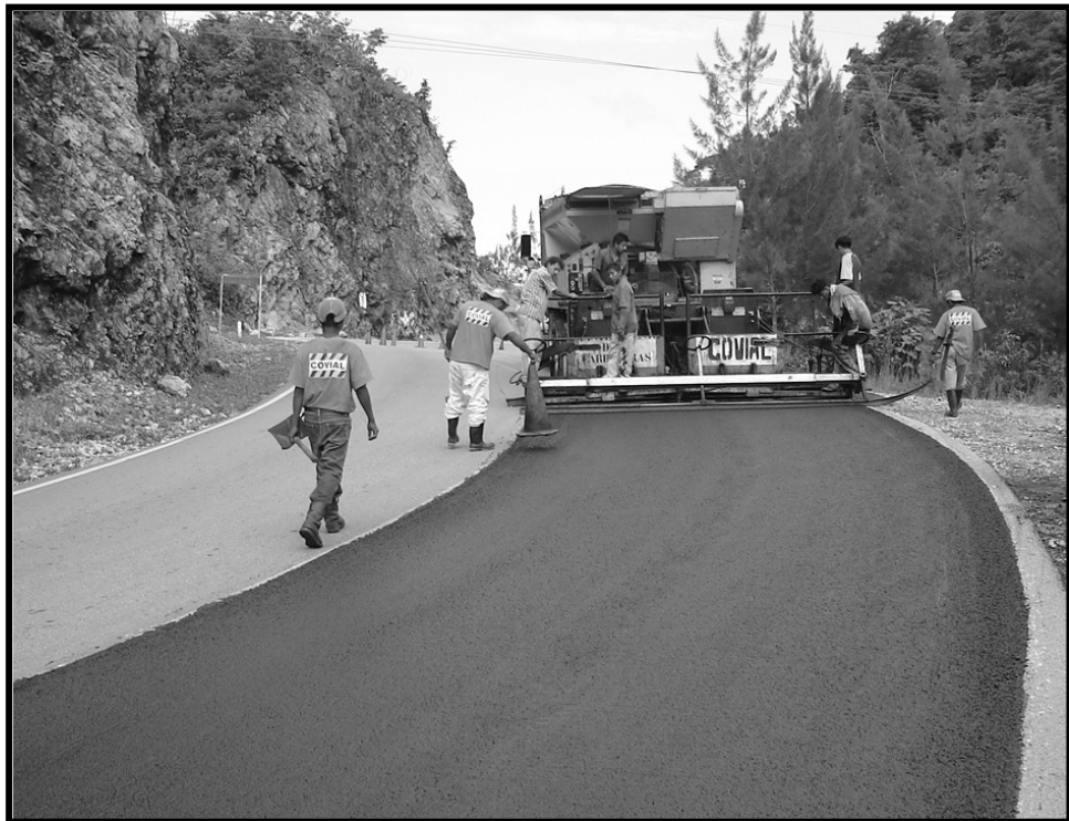
Figura 20. Trabajos de micropavimento
