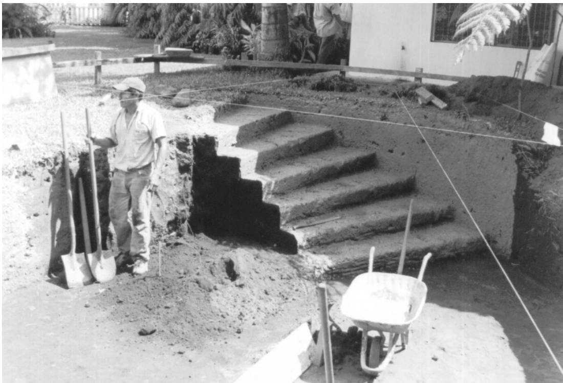
Figura 36. Excavación de estanque de piscina 3.
