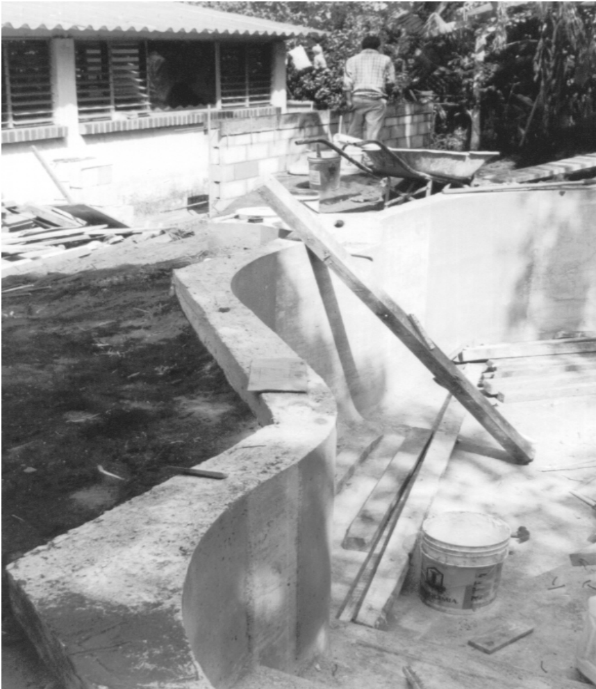
Figura 32. Paredes sin formaleta.
