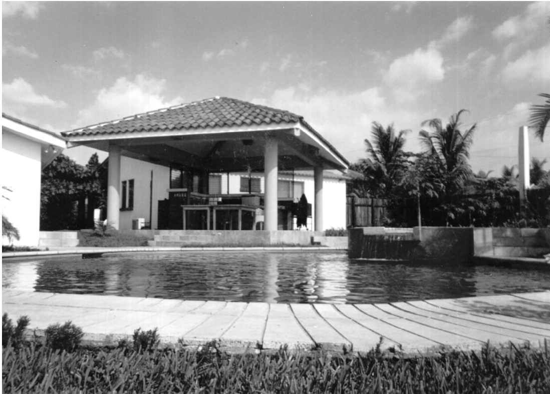
Figura 29. Panorámica del proyecto 1 terminado.
