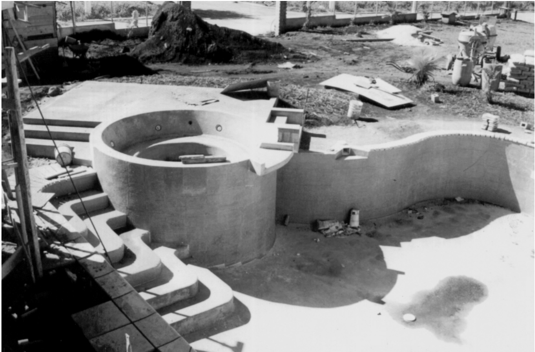
Figura 28. Colocación de mosaico en paredes y gradas.
