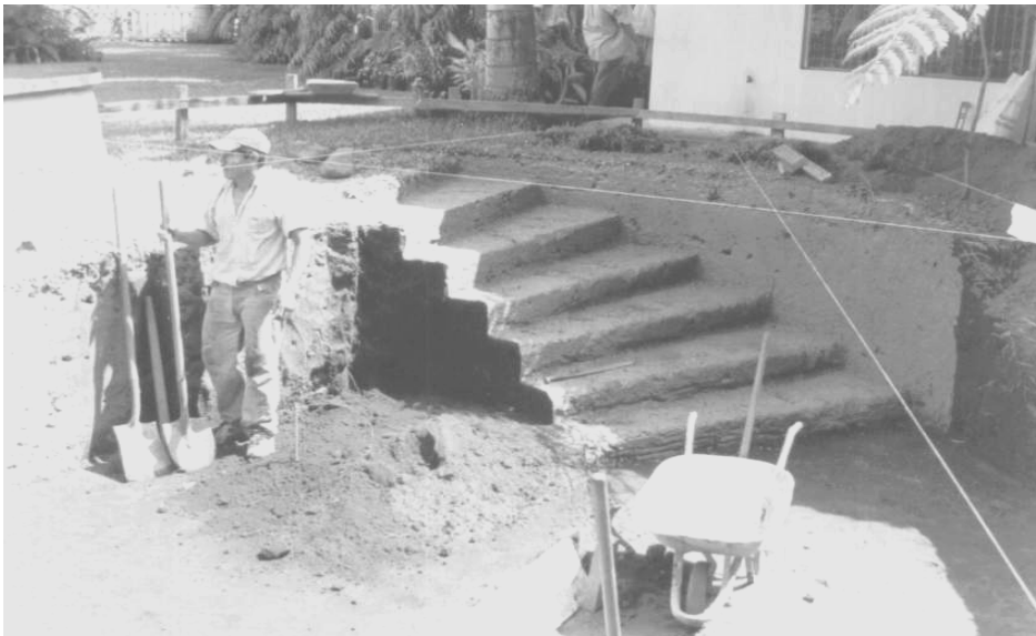
Figura 5. Excavación con paredes ensabietadas.
