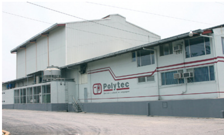
Figura 1. Vista parcial de la planta de producción de Polytec
