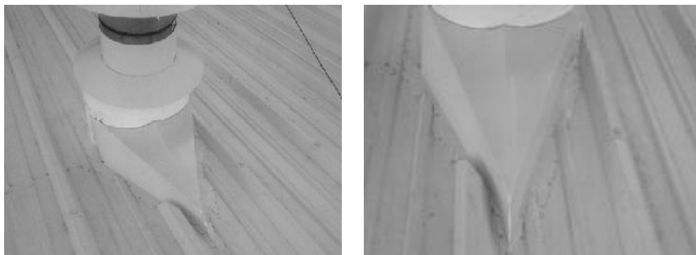
Figura 32. Sellamiento de bases de chimeneas en forma angular
