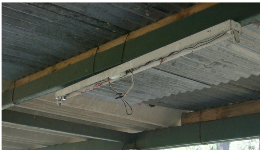
Figura 14. Pasillo de atrás, área de alimentación
