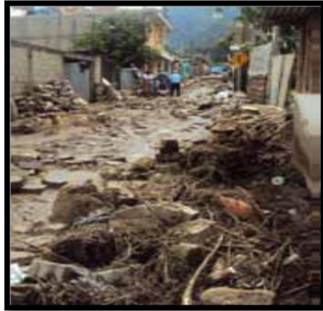
Figura 47. Daños ocurridos en La Giralda
