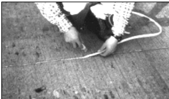
Figura 9. Colocación del cordón de respaldo en la junta longitudinal
