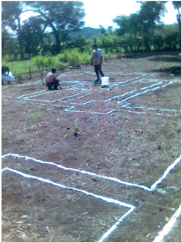
Figura 9. Disposición de la obra
