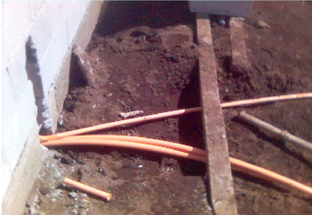
Figura 12. Conductos eléctricos enterrados
