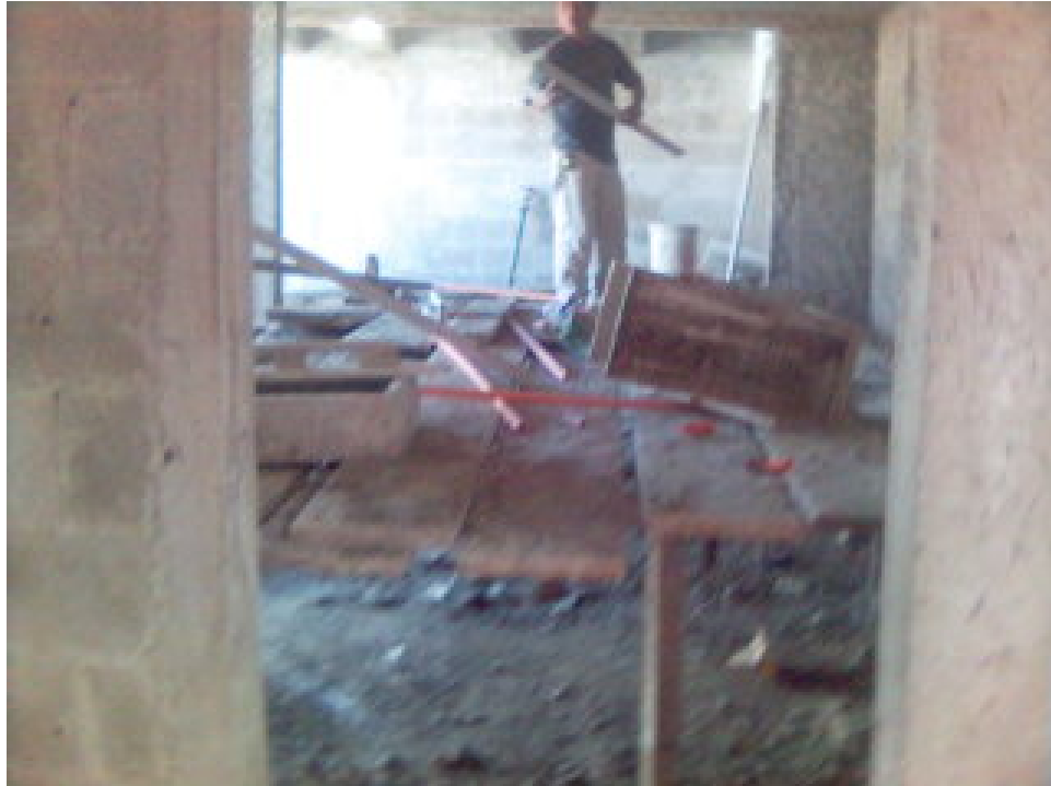
Figura 14. Plataformas de trabajo
