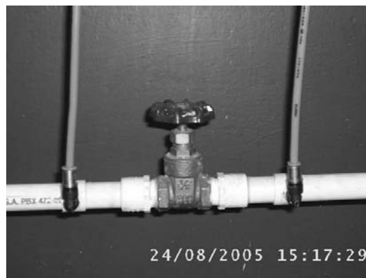
Figura 17. Conexión de mangueras con racores.
